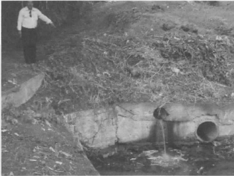
Gigoga à margem da ETE Nova Carapina
