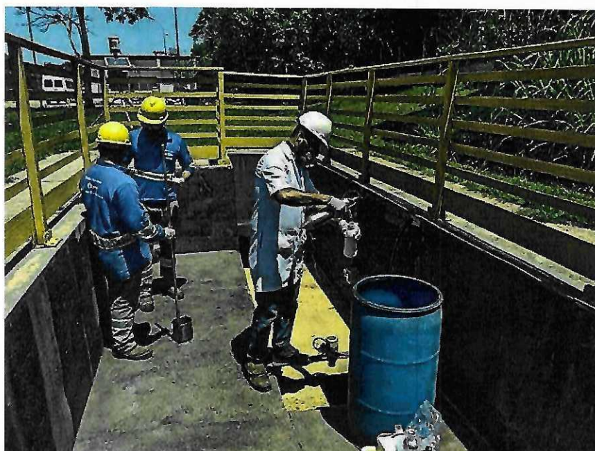
Figura 006: 6) Efluente (Saída da ETE - Manguinhos)
