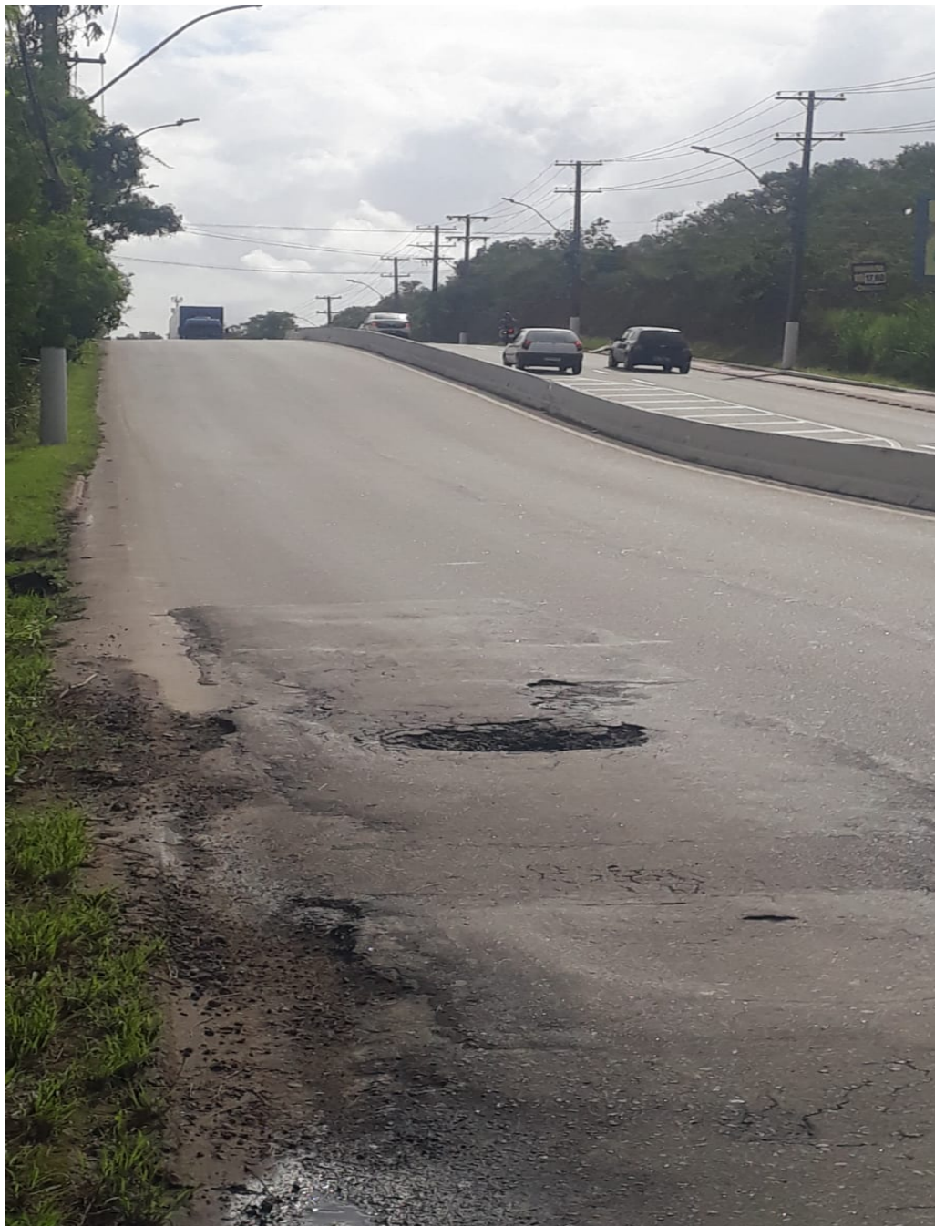
Imagem 1 - Localização Avenida Norte Sul. Fonte: Gabinete.
