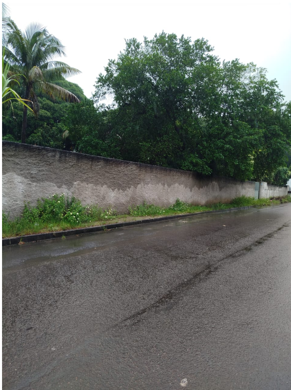
Imagem 1: Vista da Rua Leôncio Monjardim, s/n, Guaraciaba, Serra/ES. Fonte: Gabinete.
