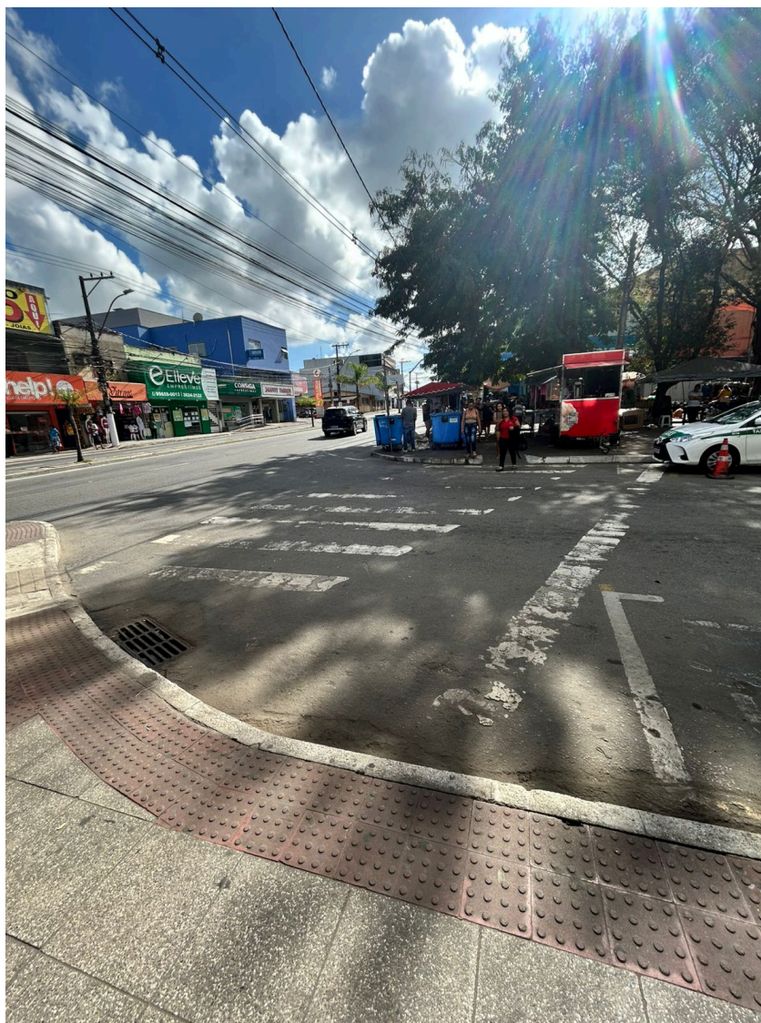
Imagem 2 – Vista da Rua Euclides da Cunha, s/n, Colina de Laranjeiras. Fonte: Gabinete.
