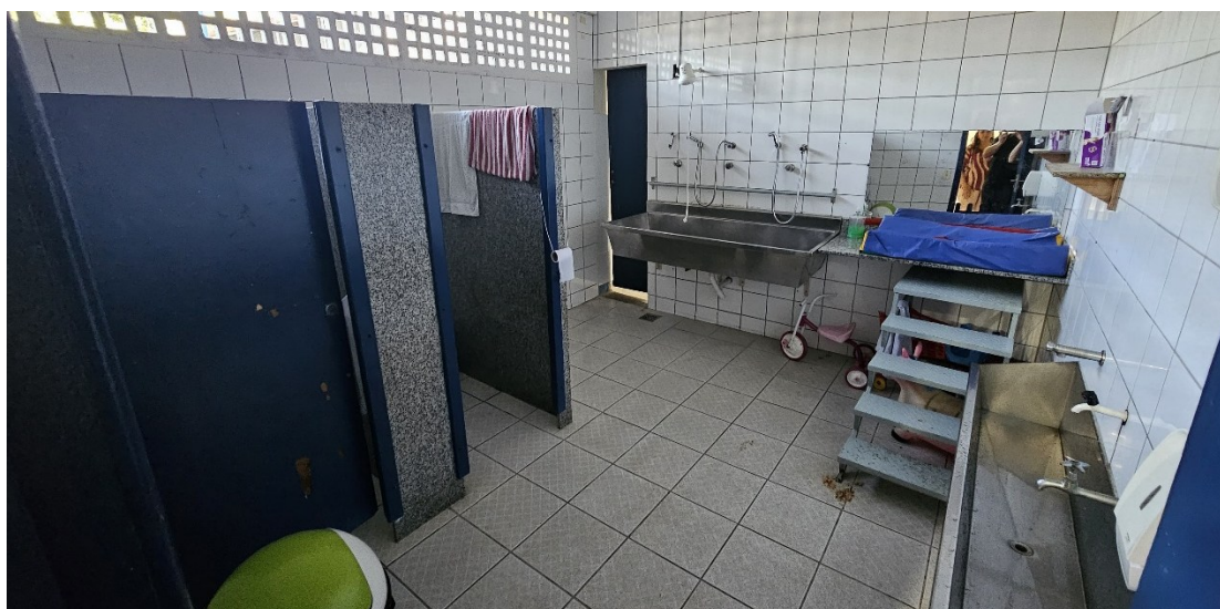
(1 (um) banheiro para o grupo 1)
