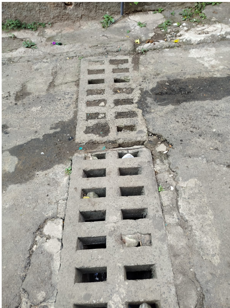
Imagem 2 – Vista da rua Goitacazes, s/n, Laranjeiras Velha, Serra/ES. Fonte: Gabinete.
