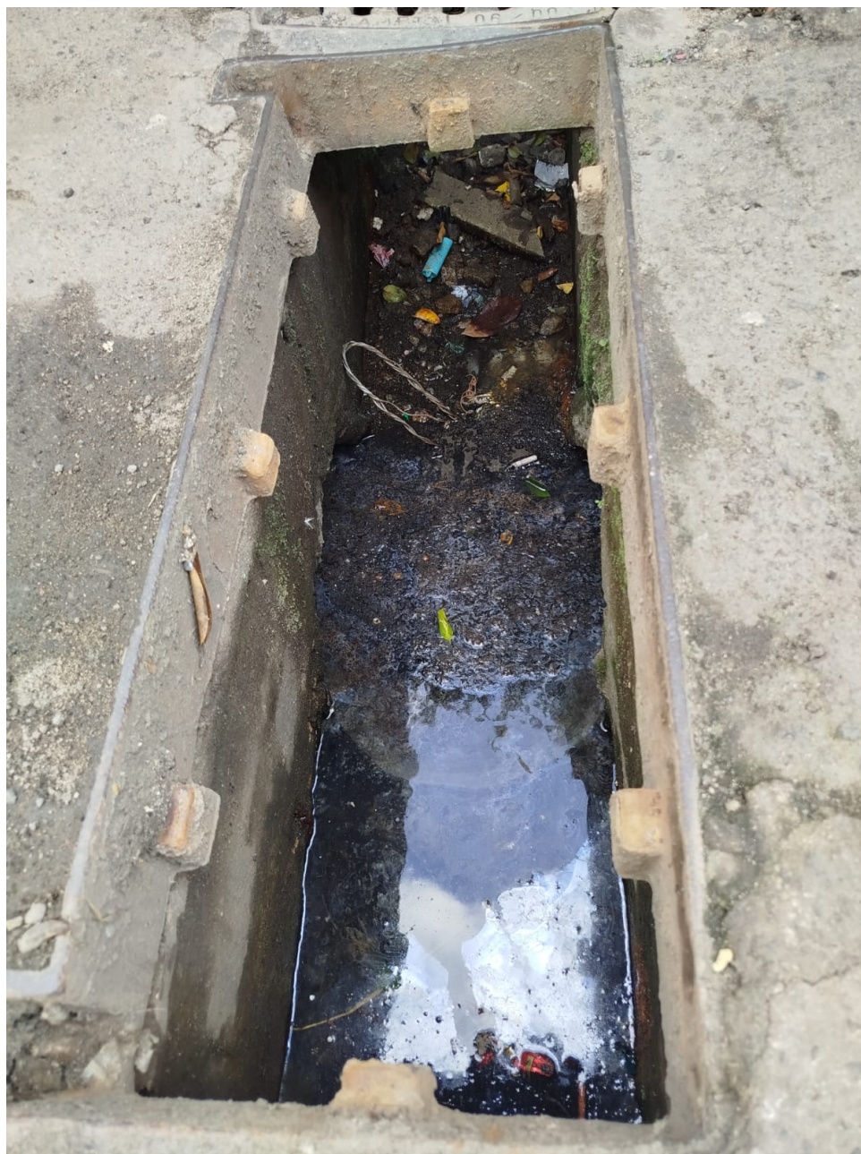
Imagem 4 – Vista da rua Goitacazes, s/n, Laranjeiras Velha, Serra/ES. Fonte: Gabinete.
