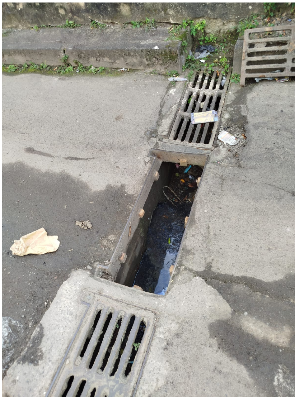
Imagem 3 – Vista da rua Goitacazes, s/n, Laranjeiras Velha, Serra/ES. Fonte: Gabinete.
