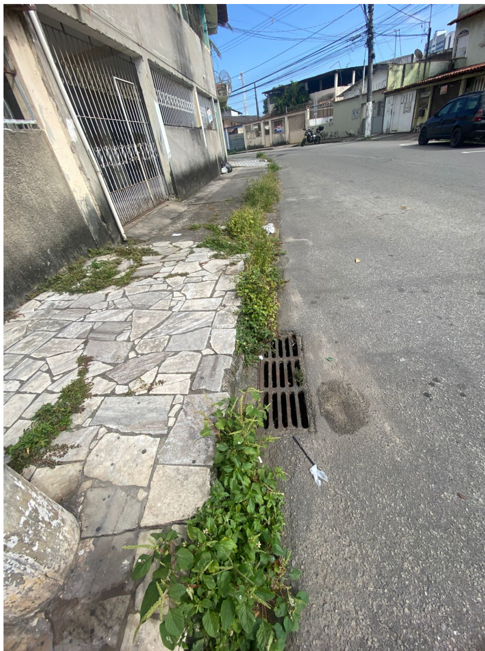
Imagem 2 - Vista da Rua Miguel Angelo, s/n, Parque Residencial Laranjeiras, Serra/ES. Fonte: Gabinete.
