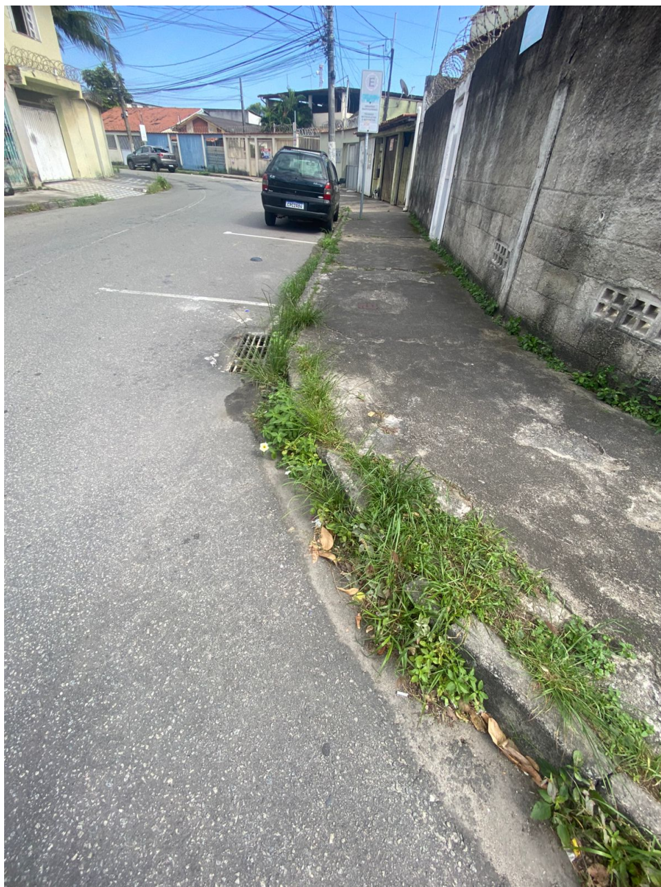
Imagem 3 - Vista da Rua Miguel Angelo, s/n, Parque Residencial Laranjeiras, Serra/ES. Fonte: Gabinete.
