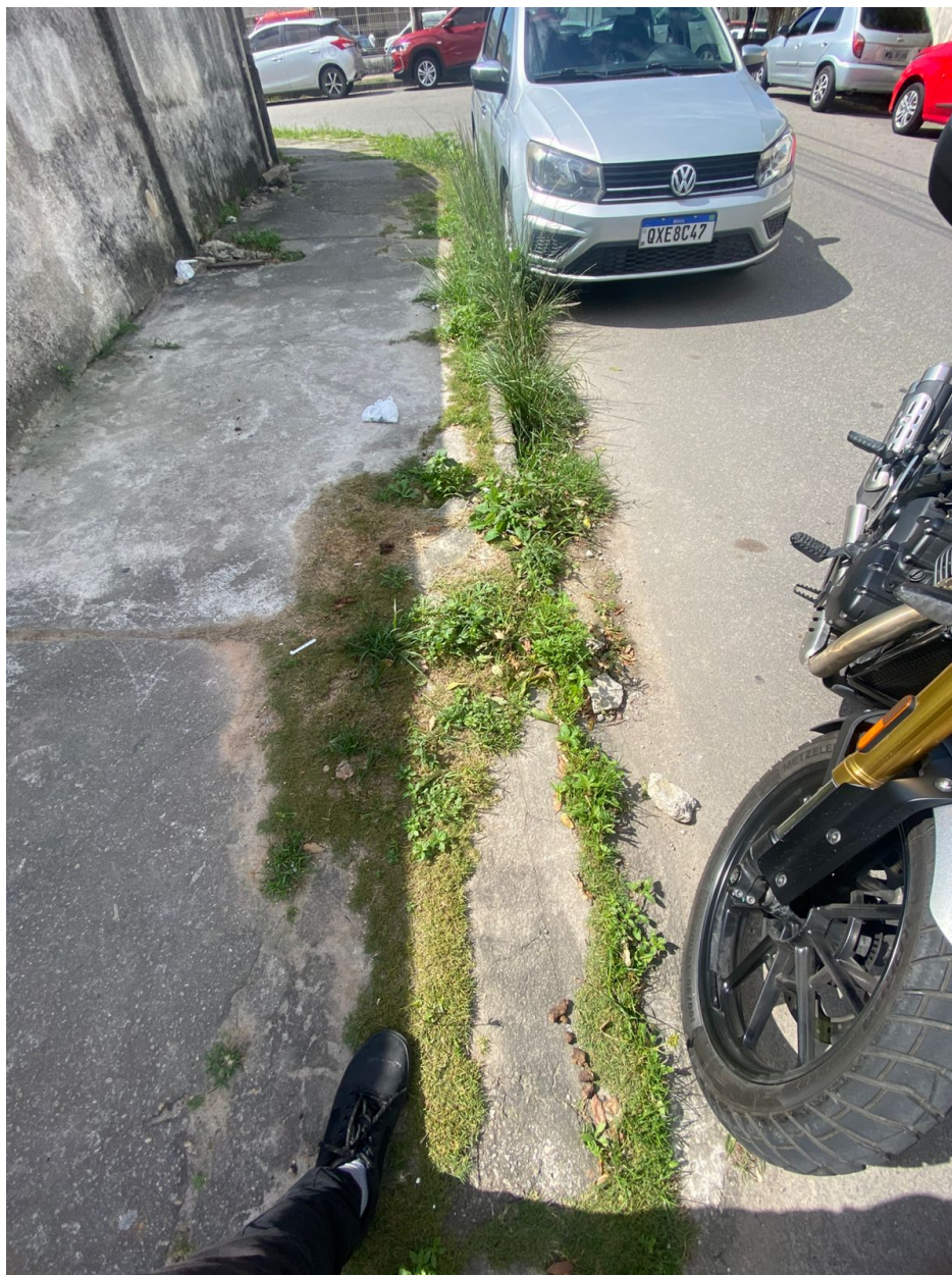
Imagem 2 - Vista da Rua Portinari, s/n, Parque Residencial Laranjeiras, Serra/ES. Fonte: Gabinete.
