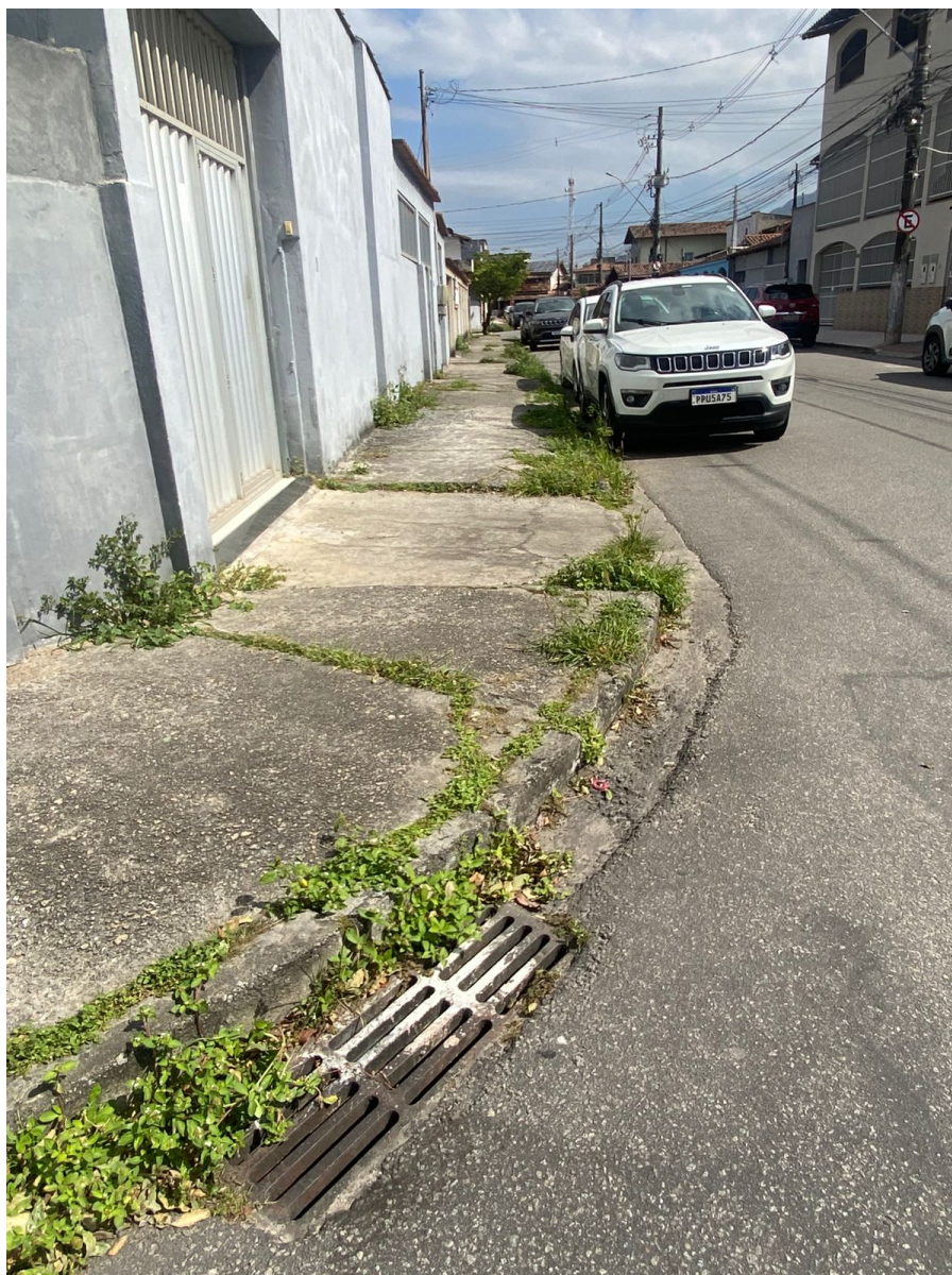
Imagem 3 - Vista da Rua Portinari, s/n, Parque Residencial Laranjeiras, Serra/ES. Fonte: Gabinete.
