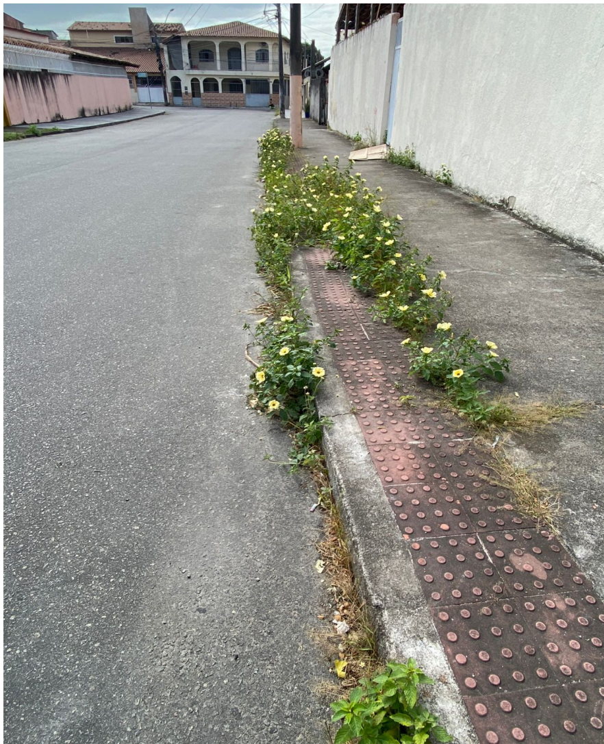
Imagem 2 - Vista da Rua José Bonifácio, s/n, Parque Residencial Laranjeiras, Serra/ES Fonte: Gabinete.
