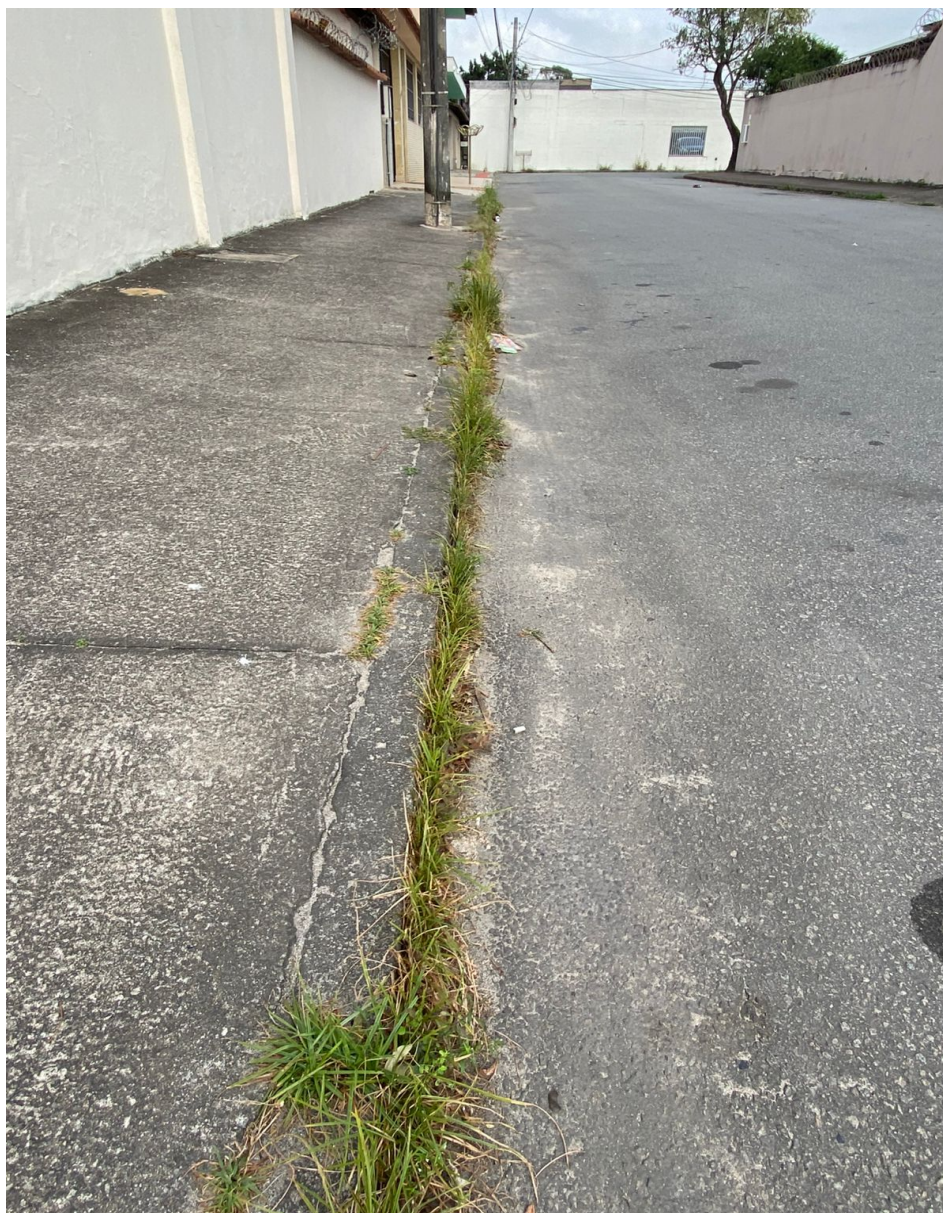
Imagem 3 - Vista da Rua José Bonifácio, s/n, Parque Residencial Laranjeiras, Serra/ES. Fonte: Gabinete.
