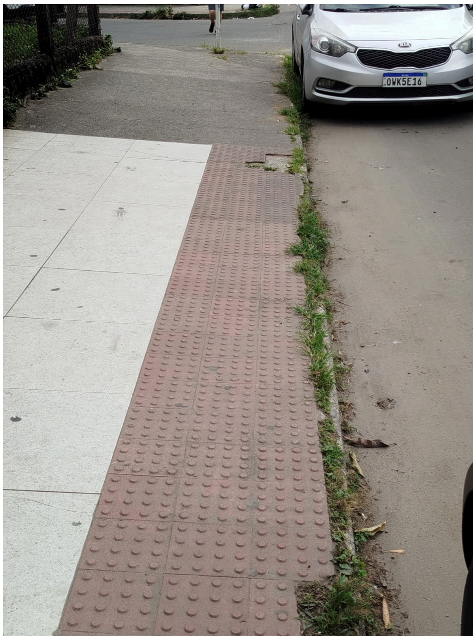
Imagem 3 – Vista da Avenida Coronel Manoel Nunes, 290, Laranjeiras Velha, Serra/ES Fonte: Gabinete.
