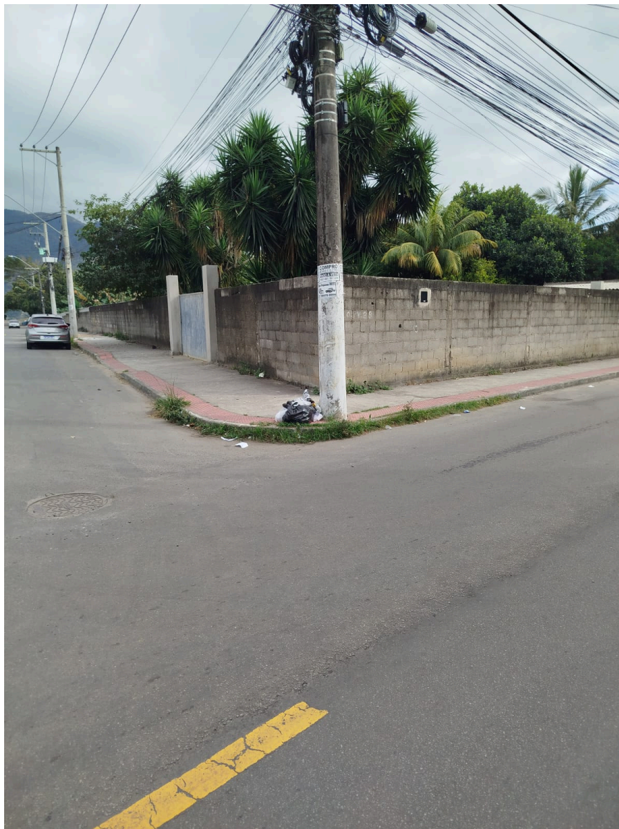
Imagem 4 – Vista da Avenida Coronel Manoel Nunes, 290, Laranjeiras Velha, Serra/ES Fonte: Gabinete.
