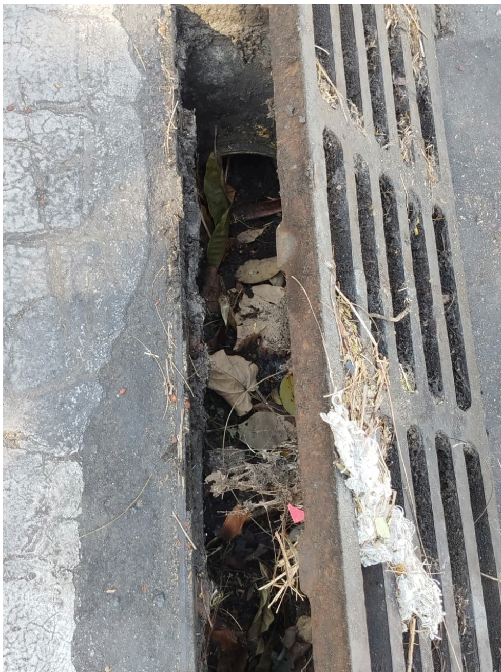
Imagem 4 - Vista da Avenida Braúna, s/n, Colina de Laranjeiras, Serra/ES. Fonte: Gabinete.
