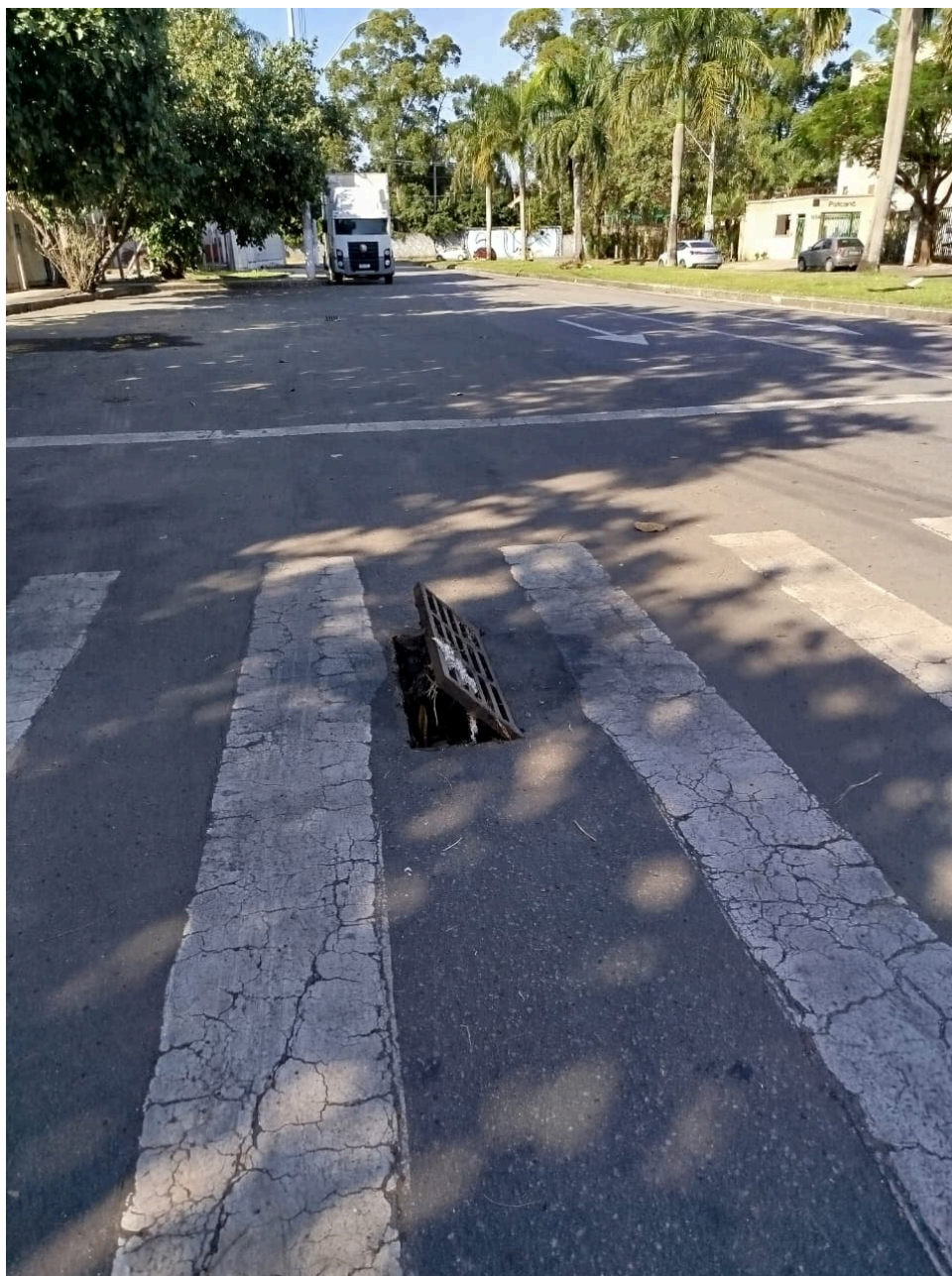
Imagem 6 - Vista da Avenida Braúna, s/n, Colina de Laranjeiras, Serra/ES. Fonte: Gabinete.
