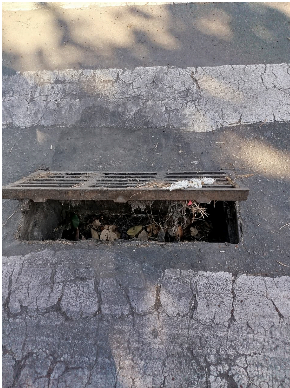
Imagem 5 - Vista da Avenida Braúna, s/n, Colina de Laranjeiras, Serra/ES. Fonte: Gabinete.
