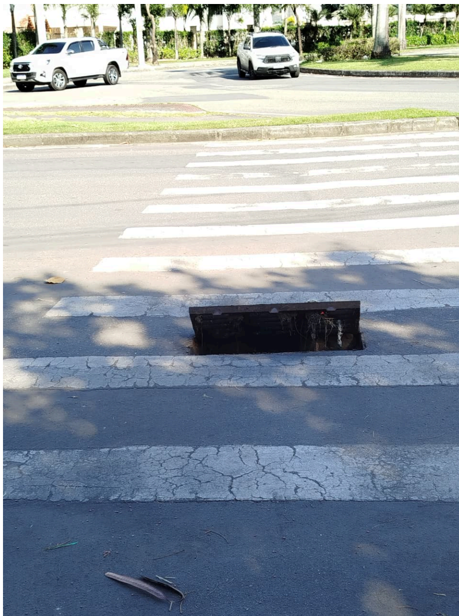
Imagem 2 - Vista da Avenida Braúna, s/n, Colina de Laranjeiras, Serra/ES. Fonte: Gabinete.
