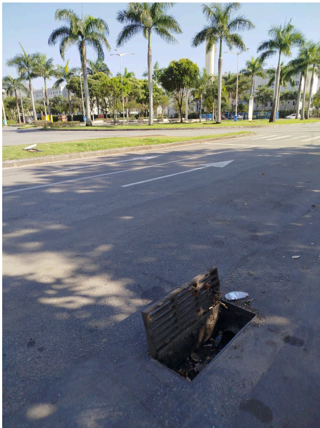
Imagem 7 - Vista da Avenida Braúna, s/n, Colina de Laranjeiras, Serra/ES. Fonte: Gabinete.
