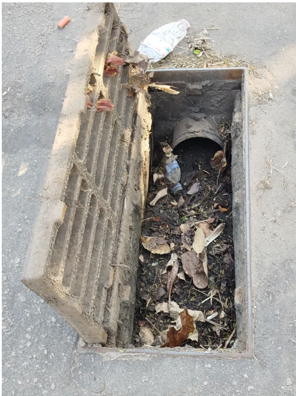
Imagem 3 - Vista da Avenida Braúna, s/n, Colina de Laranjeiras, Serra/ES. Fonte: Gabinete.
