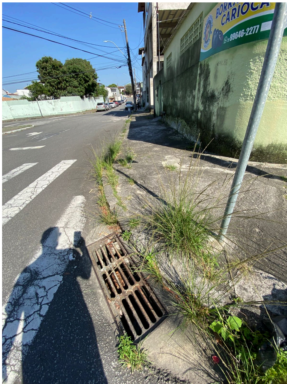
Imagem 3 – Vista da Rua Luiz Vaz de Camões, s/n, Parque Residencial Laranjeiras, Serra/ES. Fonte: Gabinete.
