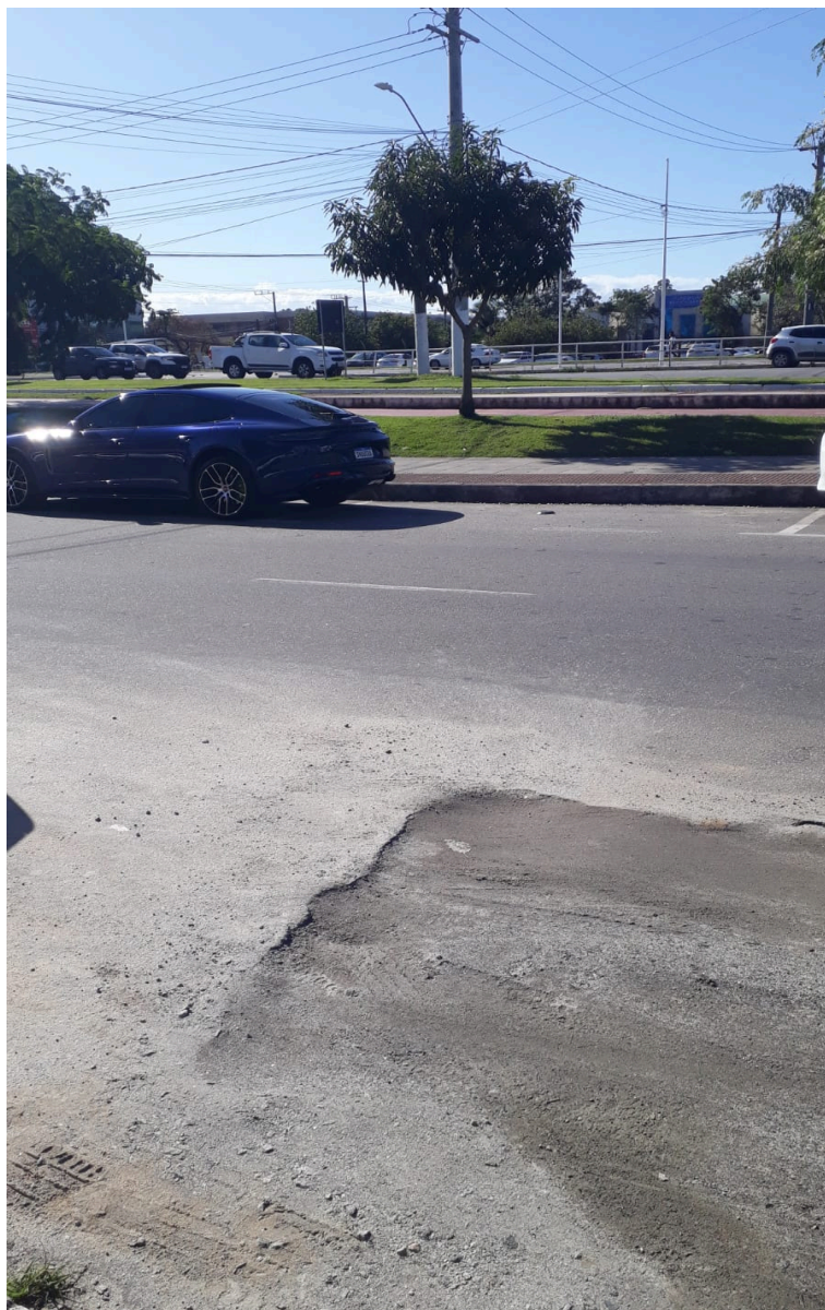
Imagem 2 - Vista da Avenida Civit, s/n, Parque Residencial Laranjeiras, Serra/ES. Fonte: Gabinete.
