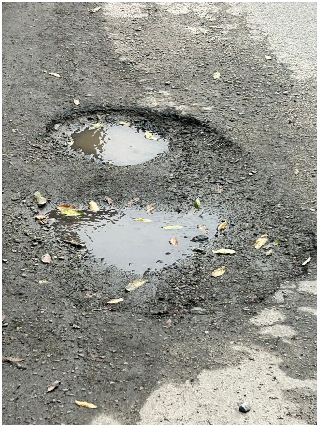
Imagem 5 - Vista da Rua Pinto, 338, Parque Residencial Laranjeiras, Serra/ES. Fonte: Gabinete.
