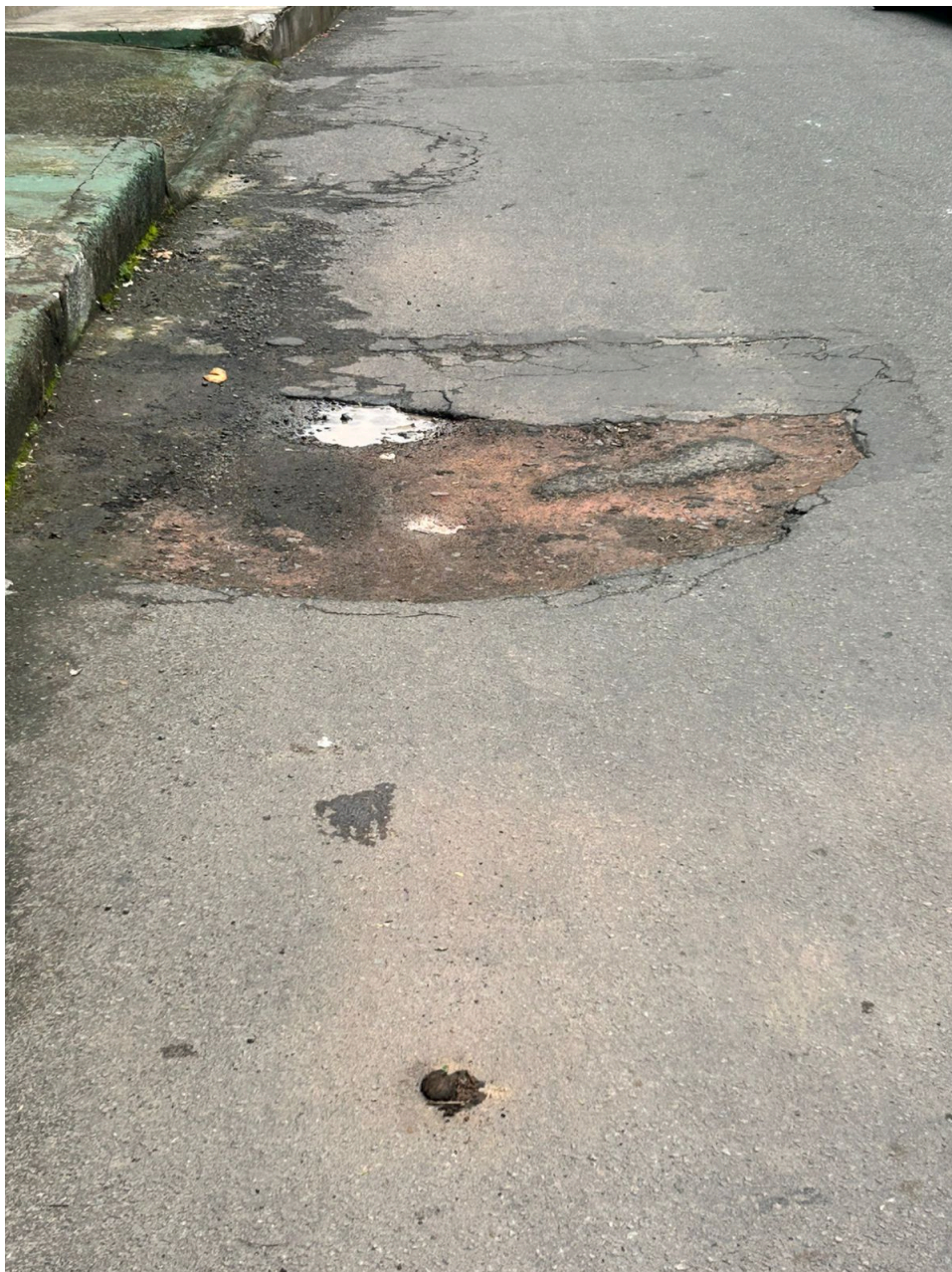
Imagem 3 - Vista da Rua Pinto, 338, Parque Residencial Laranjeiras, Serra/ES. Fonte: Gabinete.
