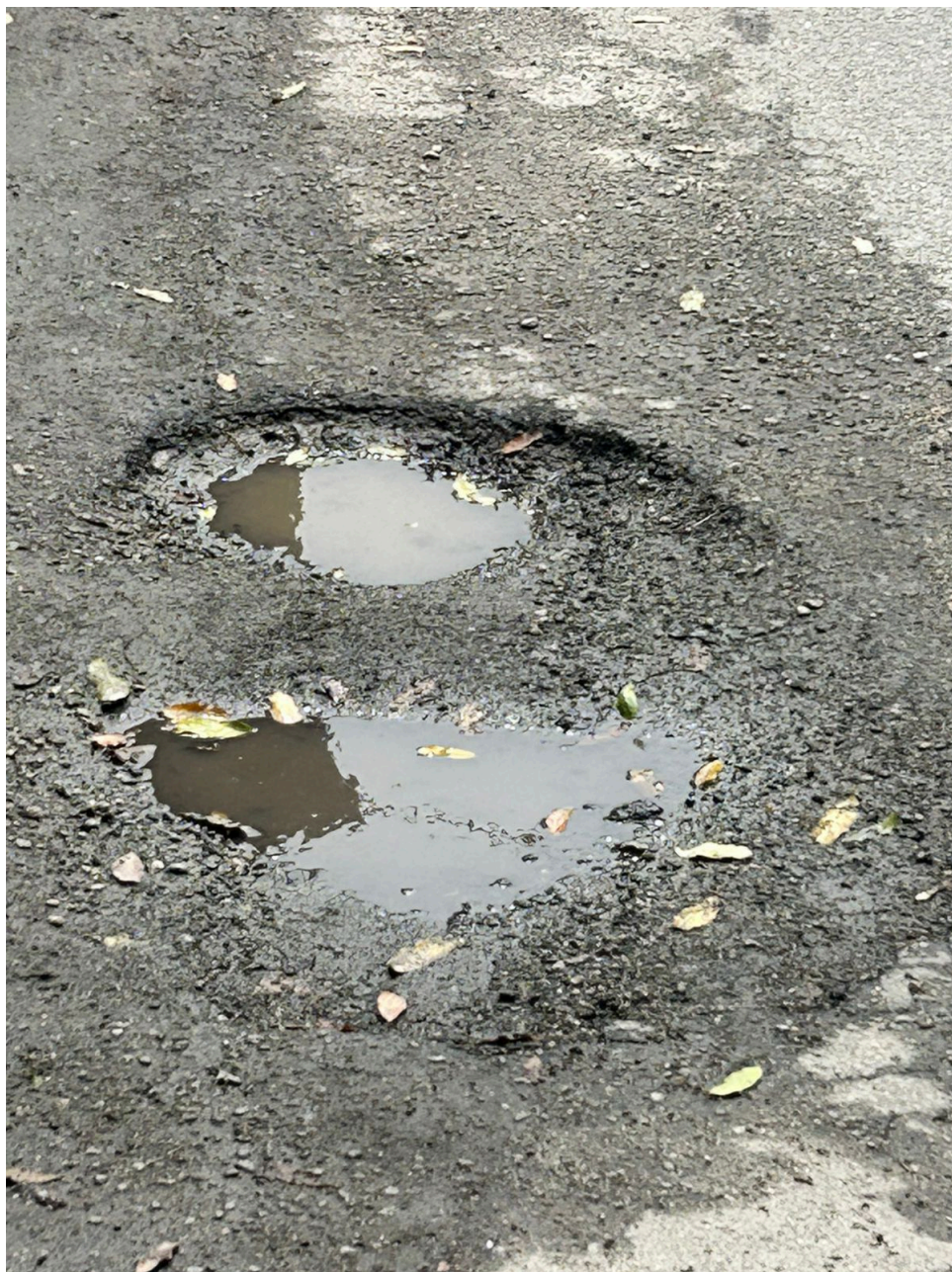
Imagem 2 - Vista da Rua Pinto, 338, Parque Residencial Laranjeiras, Serra/ES. Fonte: Gabinete.
