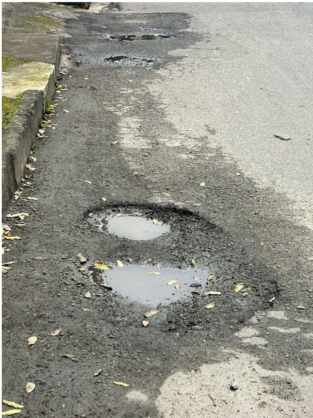
Imagem 6 - Vista da Rua Pinto, 338, Parque Residencial Laranjeiras, Serra/ES. Fonte: Gabinete.
