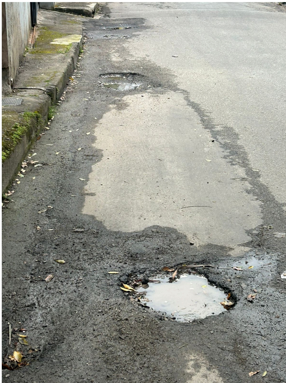
Imagem 4 - Vista da Rua Pinto, 338, Parque Residencial Laranjeiras, Serra/ES. Fonte: Gabinete.
