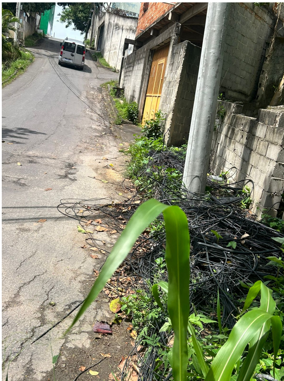
Imagem 2 - Vista da Rua Pinto, 178, Parque Residencial Laranjeiras, Serra/ES. Fonte: Gabinete.
