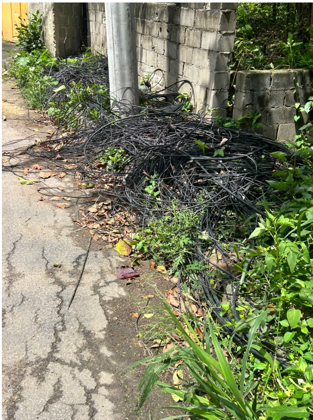
Imagem 4 - Vista da Rua Pinto, 178, Parque Residencial Laranjeiras, Serra/ES. Fonte: Gabinete.
