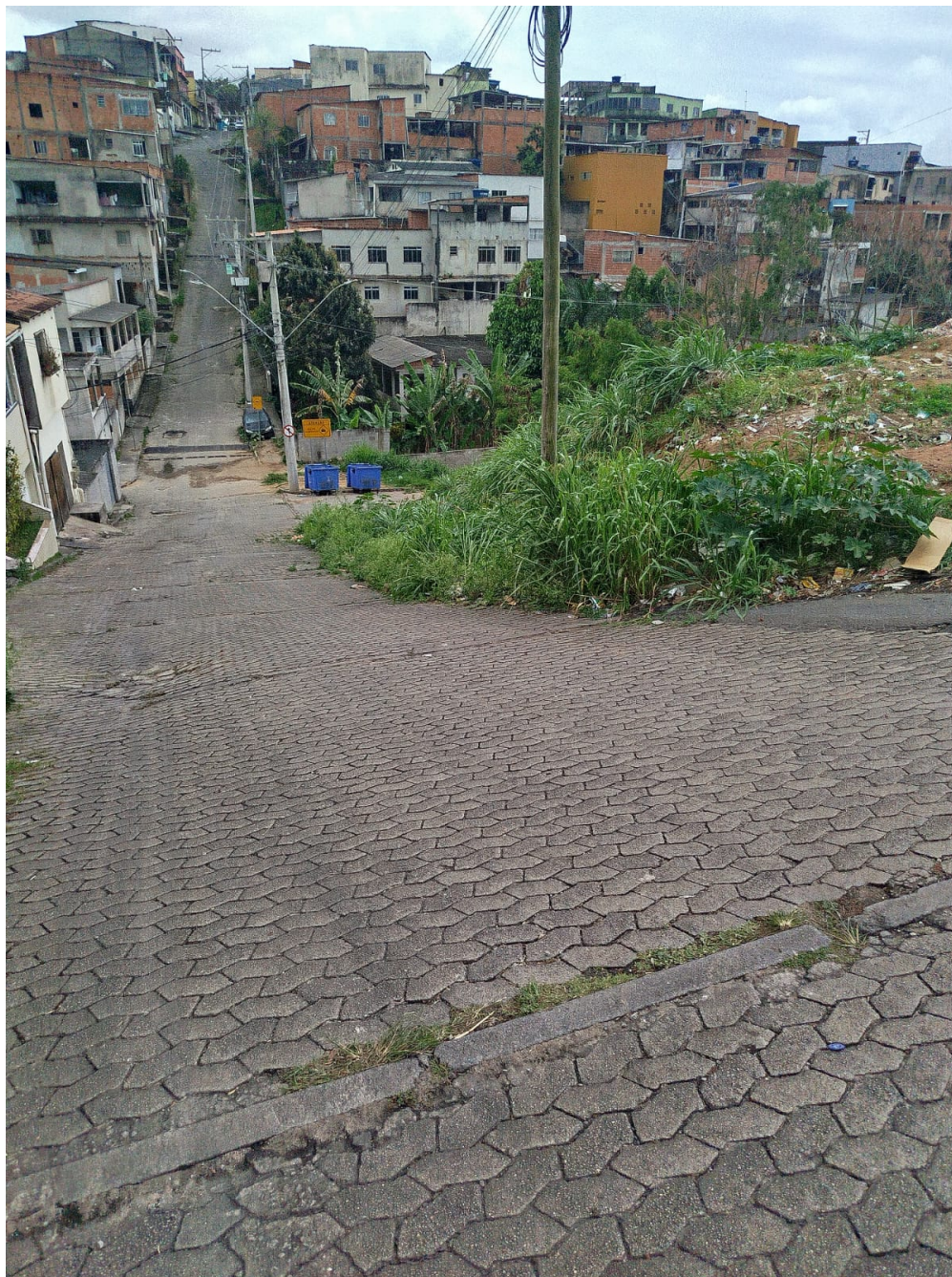
Imagem 4 - Vista da Rua José Costa Muniz, s/n, Taquara I, Serra/ ES. Fonte:Gabinete
