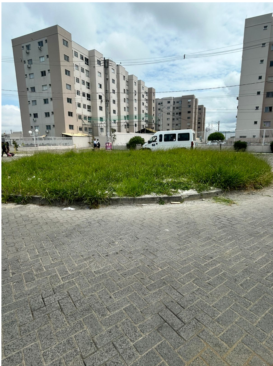
Imagem 2 - Vista da Rua Projetada 2, s/n, Porto Canoa, Serra/ ES. Fonte: Gabinete
