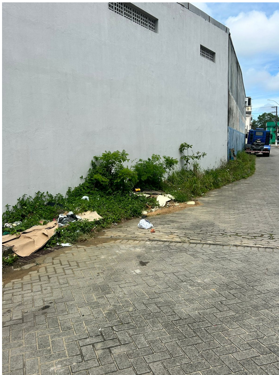
Imagem 4 - Vista da Rua Projetada 2, s/n, Porto Canoa, Serra/ ES. Fonte: Gabinete
