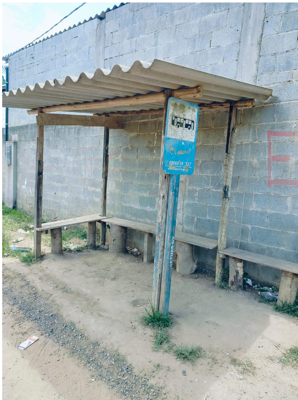
Imagem 2 - Vista da Rua Domingos Gomes de Almeida, SN, Belvedere, Serra/ES. Fonte: Munícipe.
