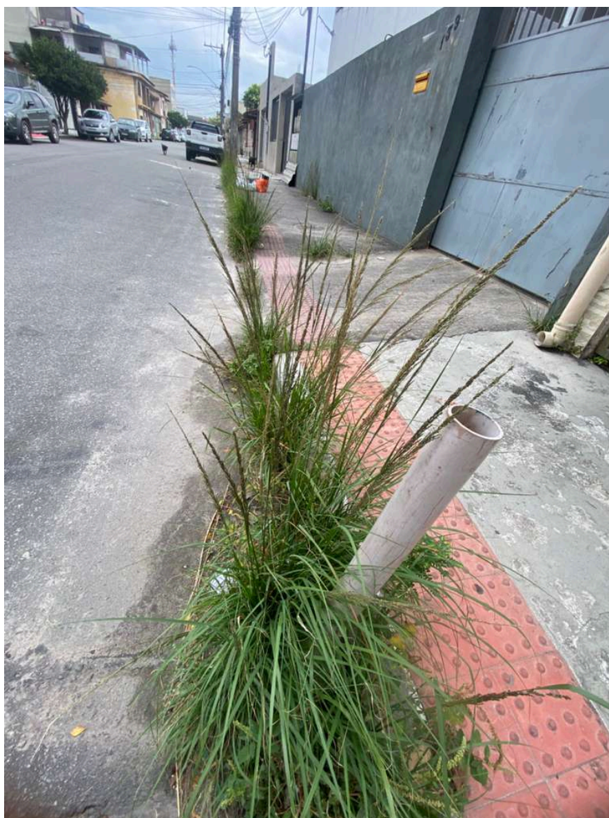
Imagem 2 – Vista da da Rua Rio Branco, s/n, Parque Residencial Laranjeiras, Serra/ES. Fonte: Gabinete.
