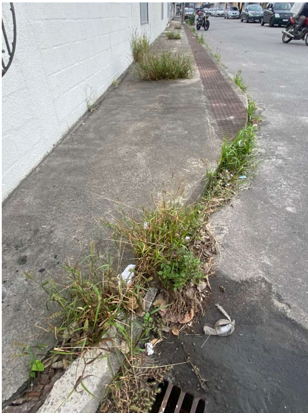
Imagem 3 - Vista da Rua José Bonifácio, s/n, Parque Residencial Laranjeiras, Serra/ES. Fonte: Gabinete.
