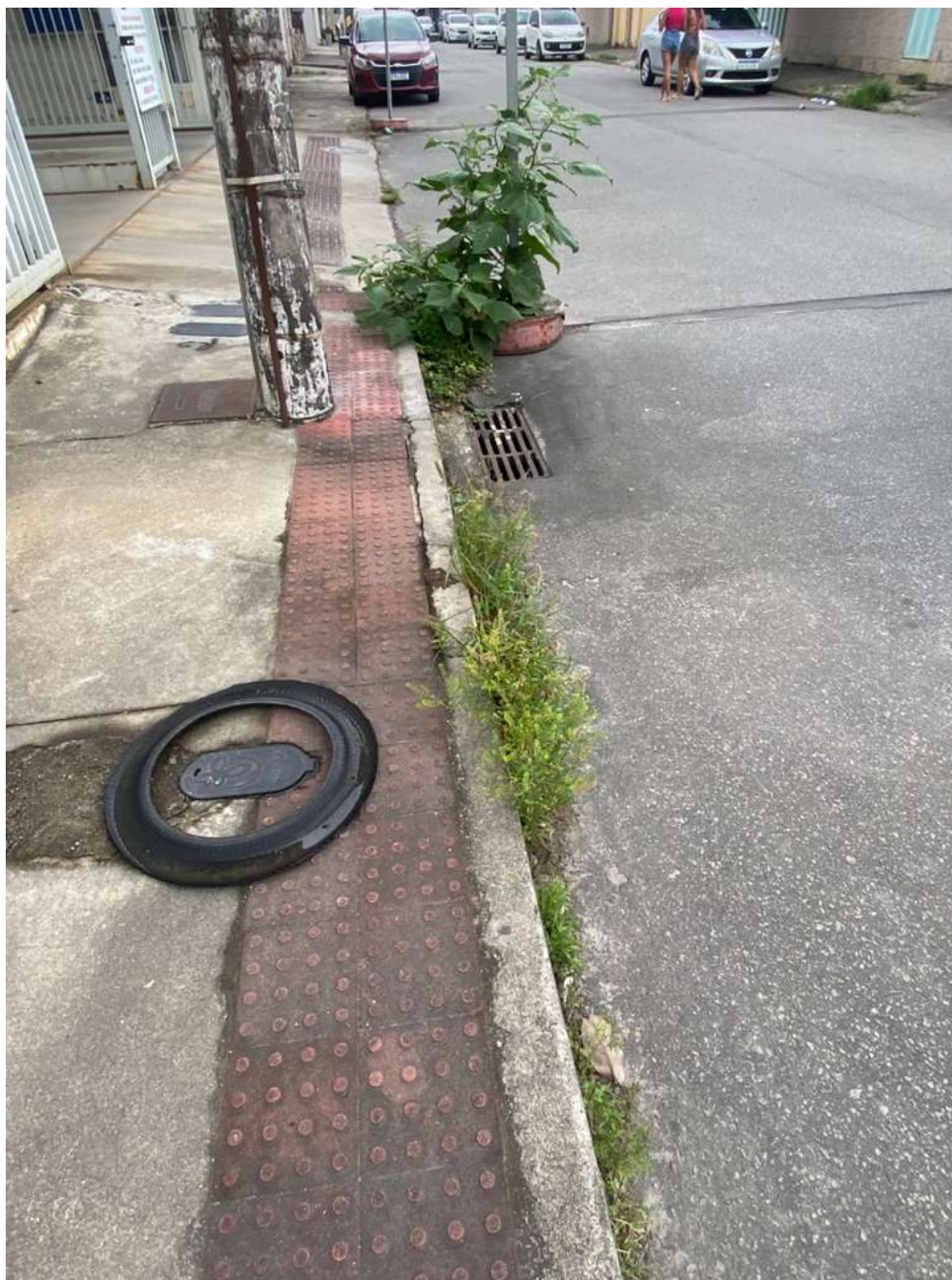
Imagem 4 - Vista da Rua José Bonifácio, s/n, Parque Residencial Laranjeiras, Serra/ES. Fonte: Gabinete.
