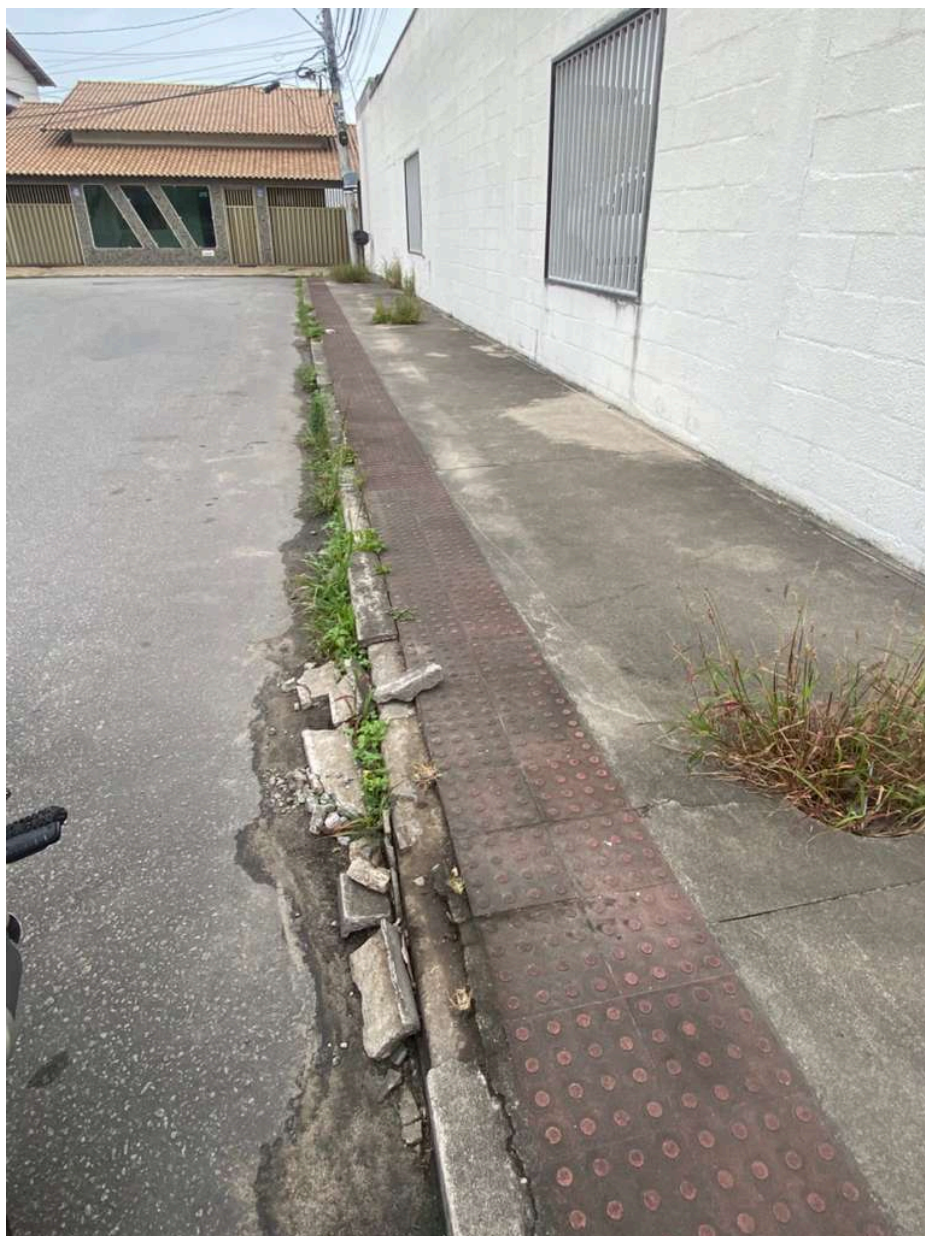
Imagem 2 - Vista da Rua José Bonifácio, s/n, Parque Residencial Laranjeiras, Serra/ES Fonte: Gabinete.
