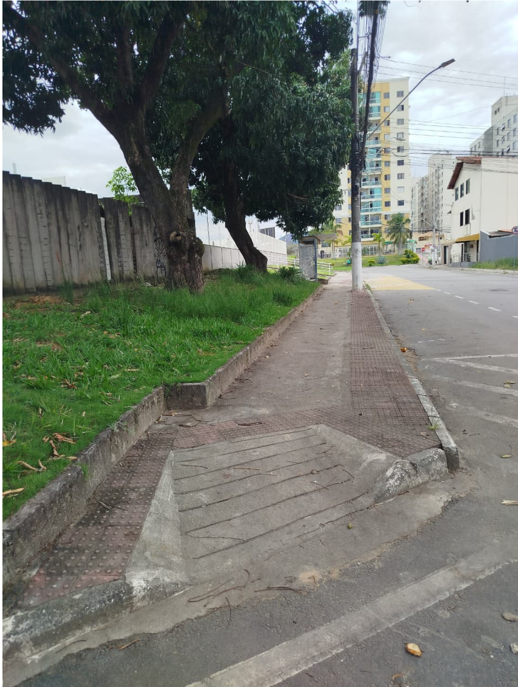
Imagem 5 - Vista da Avenida Anchieta,, s/n, Valparaíso, Serra/ES. Fonte: Gabinete.
