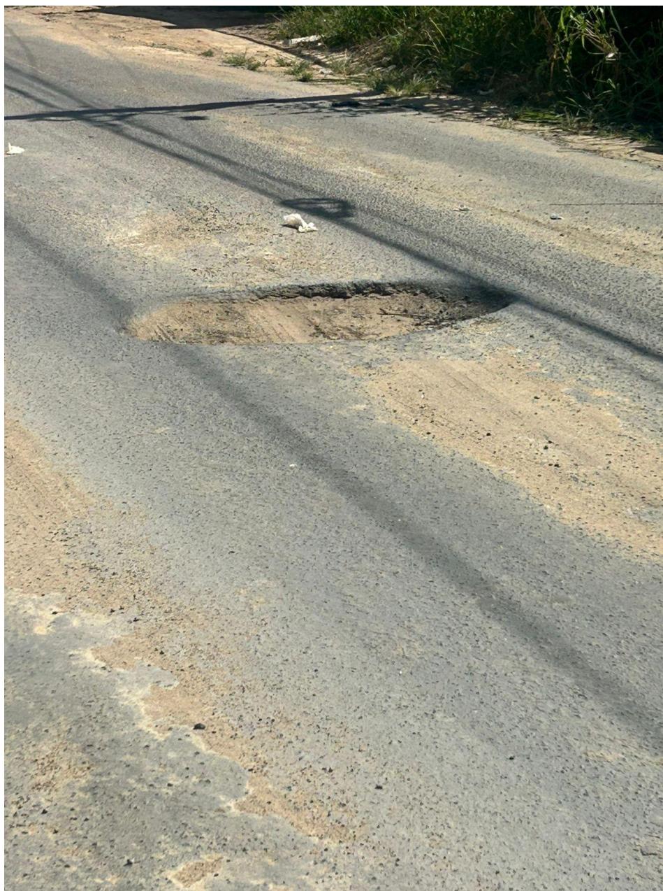
Imagem 2 - Vista da Rua Coelho Neto, s/n, Jardim Limoeiro, Serra/ES. Fonte:Gabinete.
