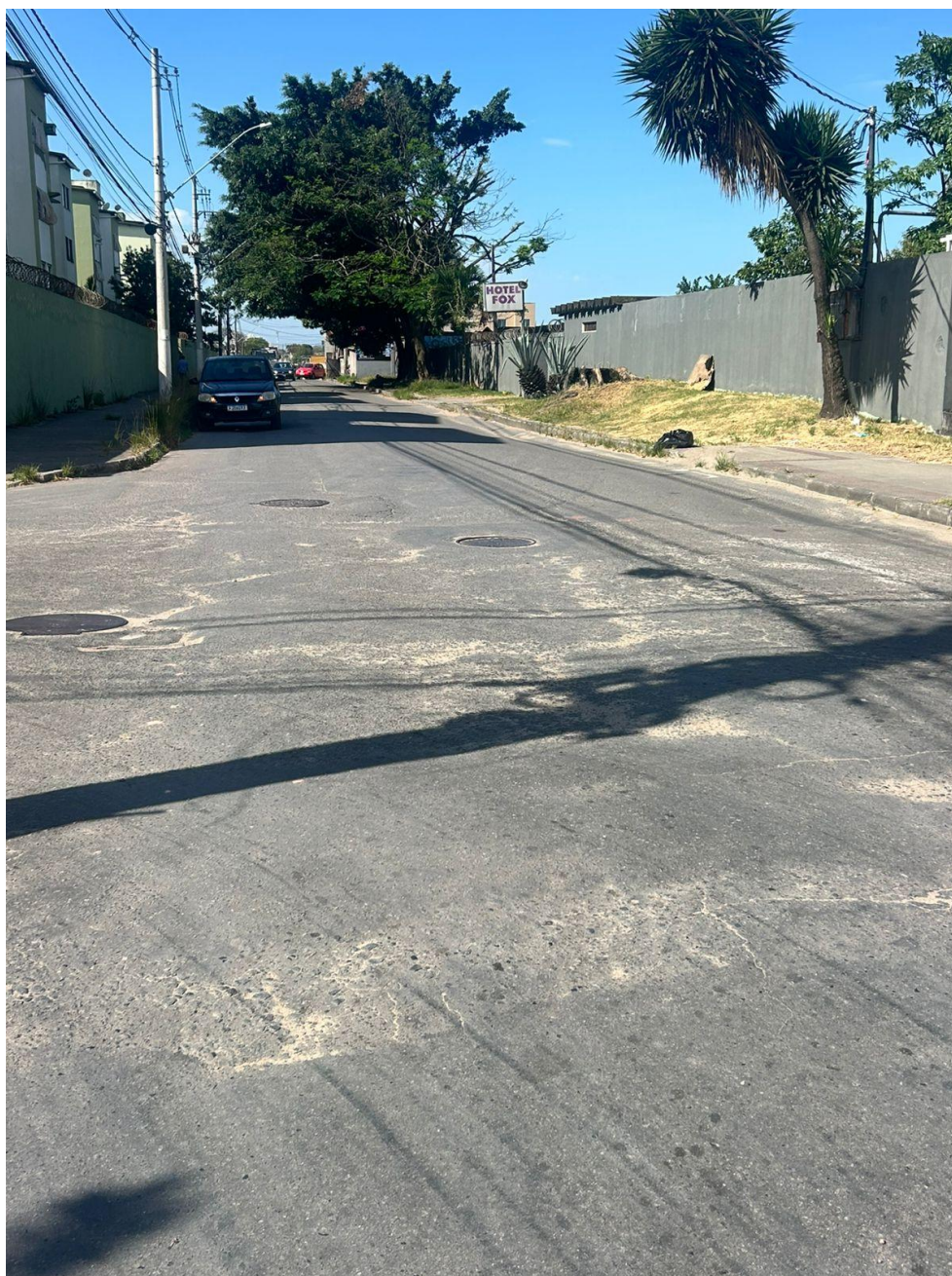
Imagem 3 - Vista da Rua Coelho Neto, s/n, Jardim Limoeiro, Serra/ES. Fonte: Gabinete.
