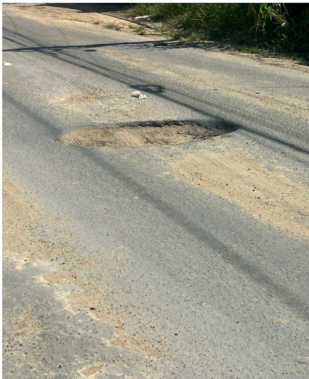
Imagem 2 - Vista da Rua Coelho Neto, s/n, Jardim Limoeiro, Serra/ES. Fonte:Gabinete.
