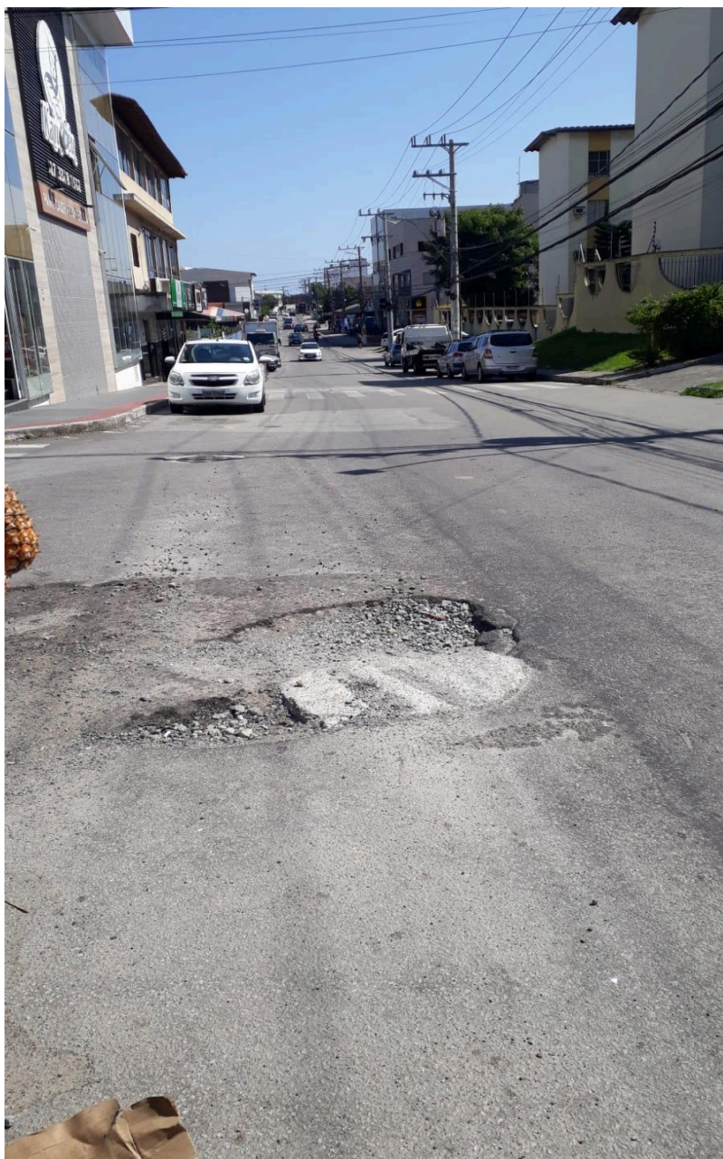
Imagem 3 - Vista da Rua Santos Dumont, nº 91, Valparaíso, Serra - ES. Fonte: Gabinete.
