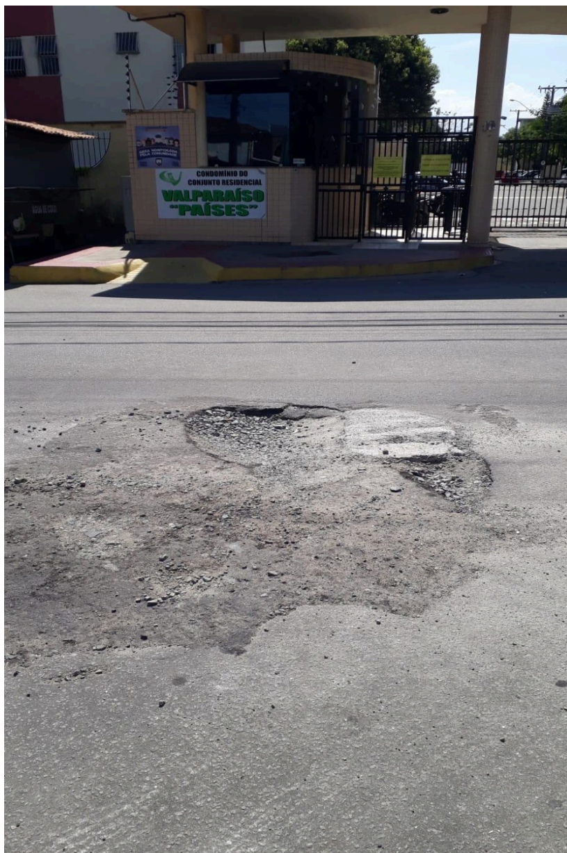
Imagem 2 - Vista da Rua Santos Dumont, nº 91, Valparaíso, Serra - ES. Fonte: Gabinete.
