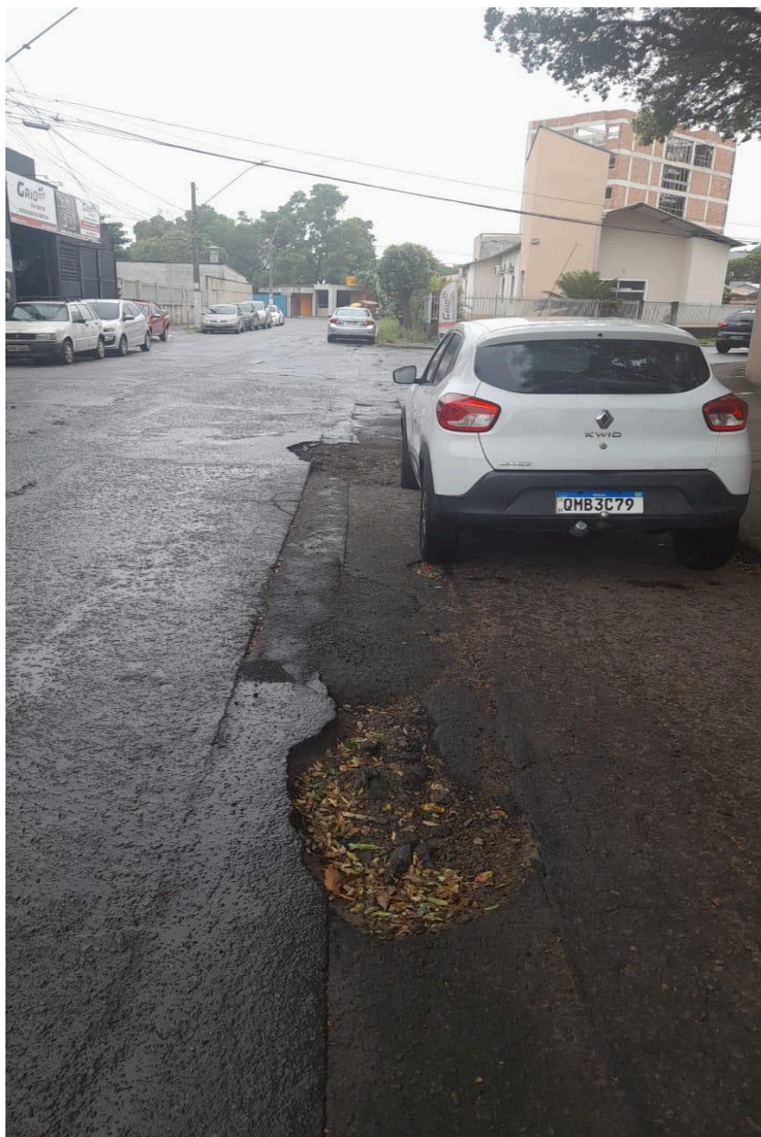
Imagem 2 - Vista da Rua Basílio da Gama, nº 05, Chácara Parreiral, Serra - ES. Fonte: Gabinete.
