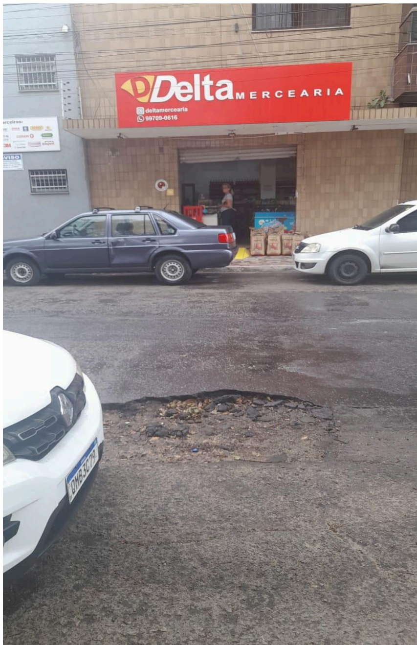
Imagem 3 - Vista da Rua Basílio da Gama, nº 05, Chácara Parreiral, Serra - ES. Fonte: Gabinete.
