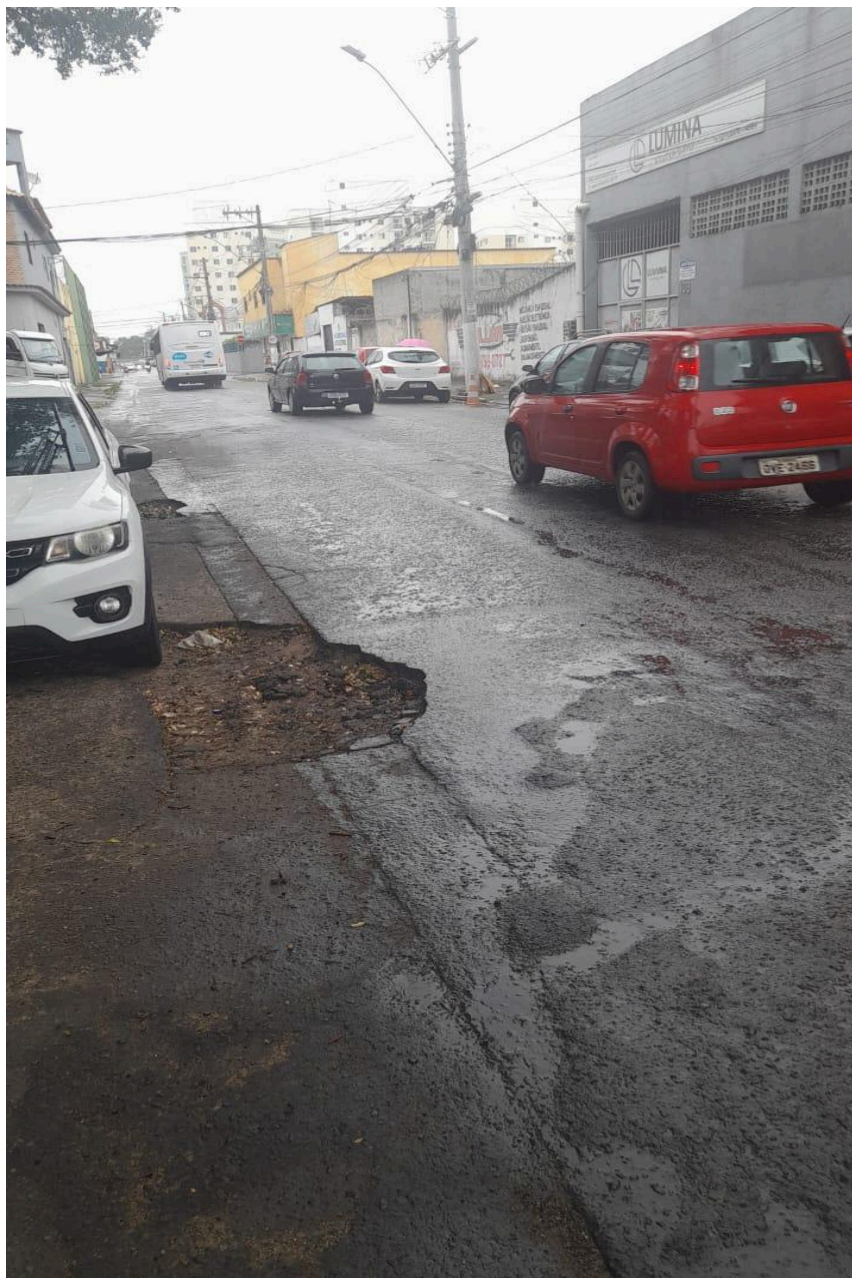
Imagem 4 - Vista da Rua Basílio da Gama, nº 05, Chácara Parreiral, Serra - ES. Fonte: Gabinete.
