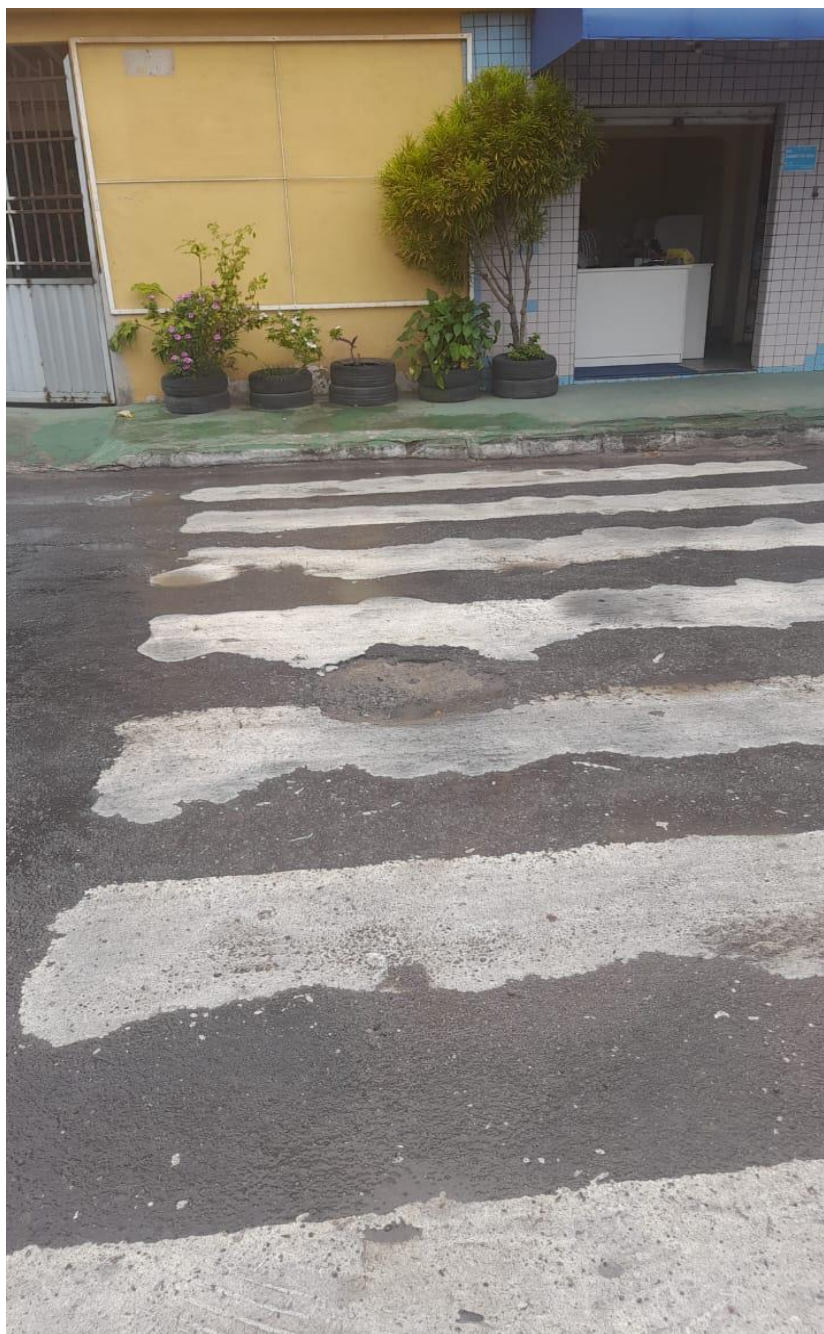
Imagem 2 - Vista da Rua Evaristo da Veiga, nº 09, Chácara Parreiral, Serra - ES. Fonte: Gabinete.
