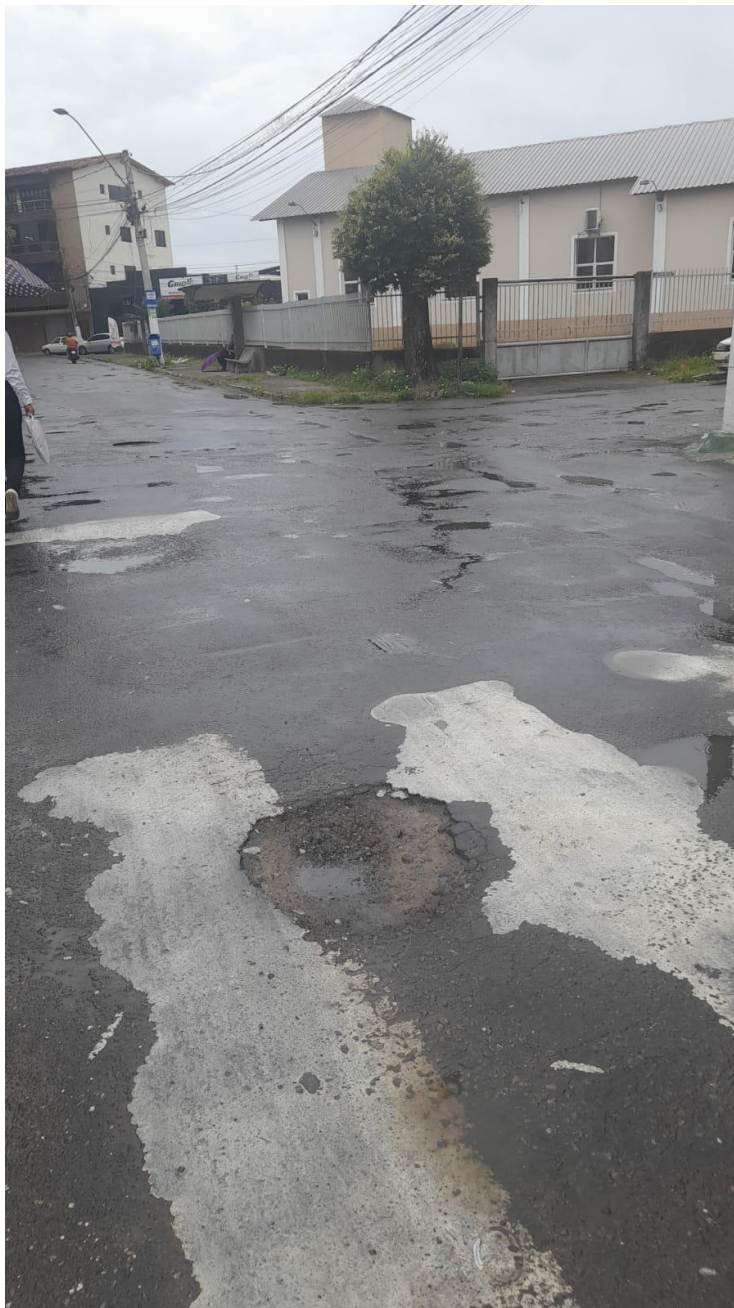
Imagem 3 - Vista da Rua Evaristo da Veiga, nº 09, Chácara Parreiral, Serra - ES. Fonte: Gabinete.
