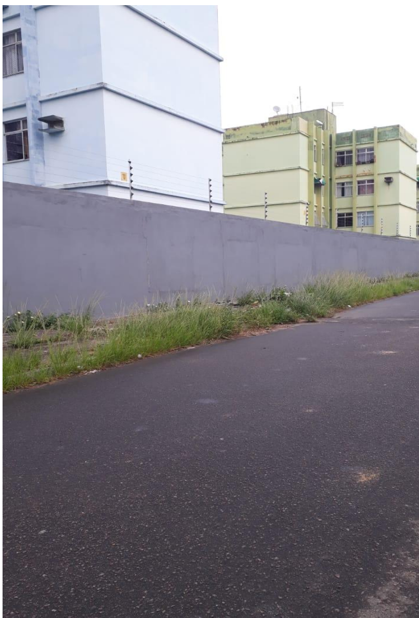
Imagem 2 - Vista da Rua Adhemar Furtado de Miranda, sn, Chácara Parreiral, Serra - ES.. Fonte: Gabinete.
