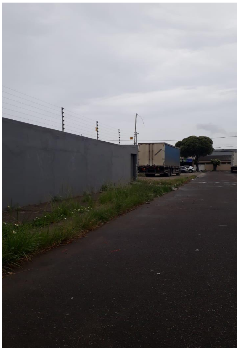
Imagem 4 - Vista da Rua Adhemar Furtado de Miranda, sn, Chácara Parreiral, Serra - ES. Fonte: Gabinete.
