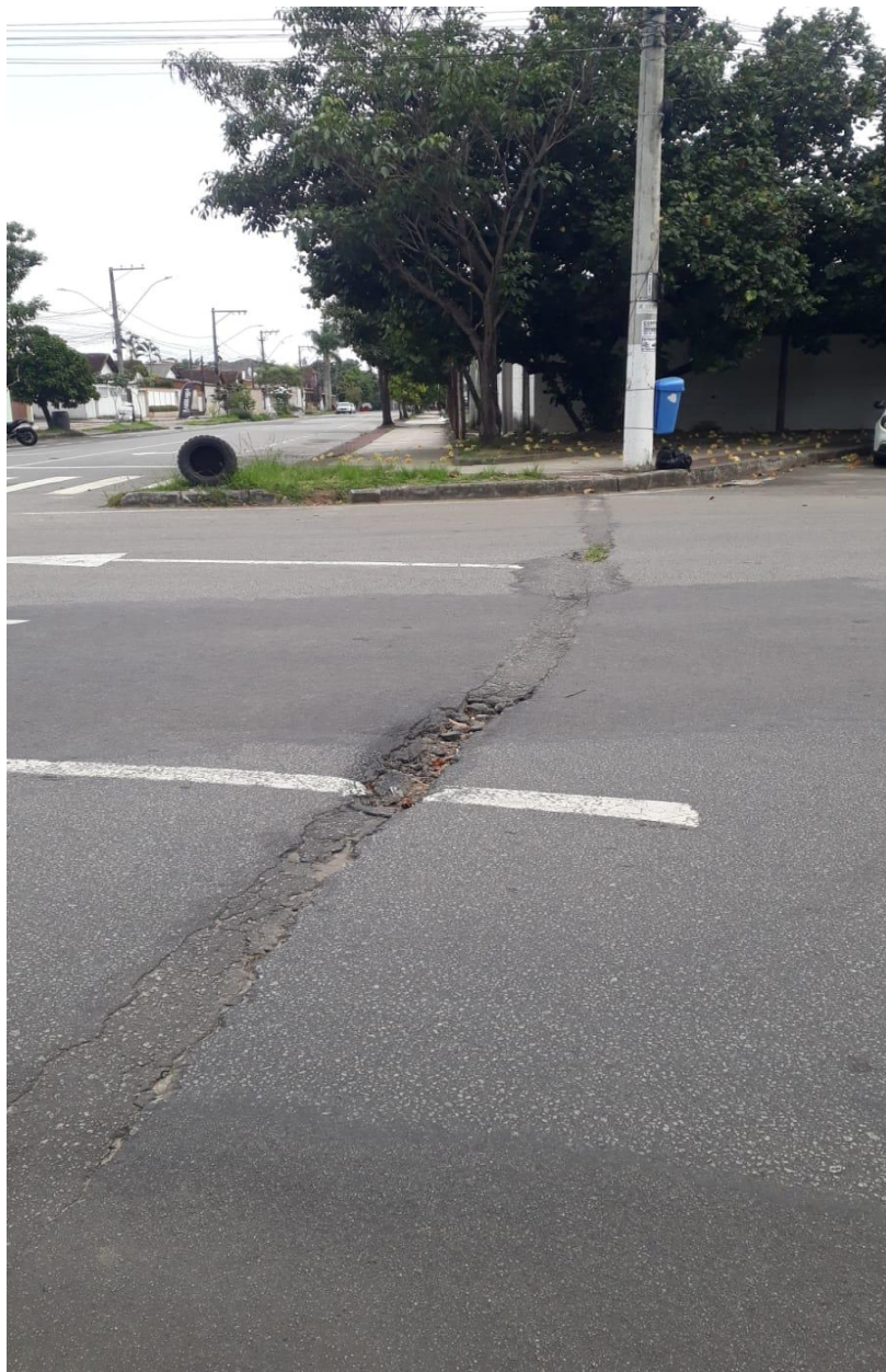
Imagem 2 - Vista da Avenida Braúna, s/n, Colina de Laranjeiras, Serra/ES. Fonte: Gabinete.
