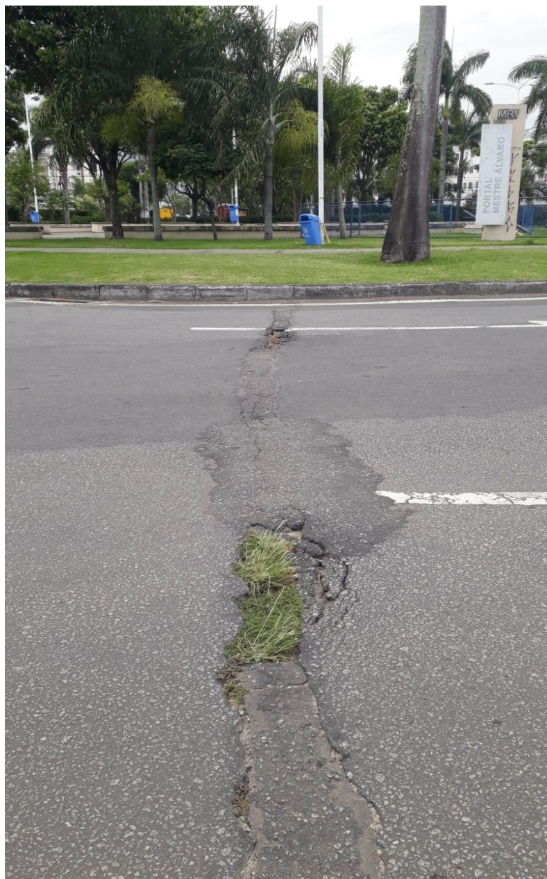
Imagem 3 - Vista da Avenida Braúna, s/n, Colina de Laranjeiras, Serra/ES. Fonte: Gabinete.
