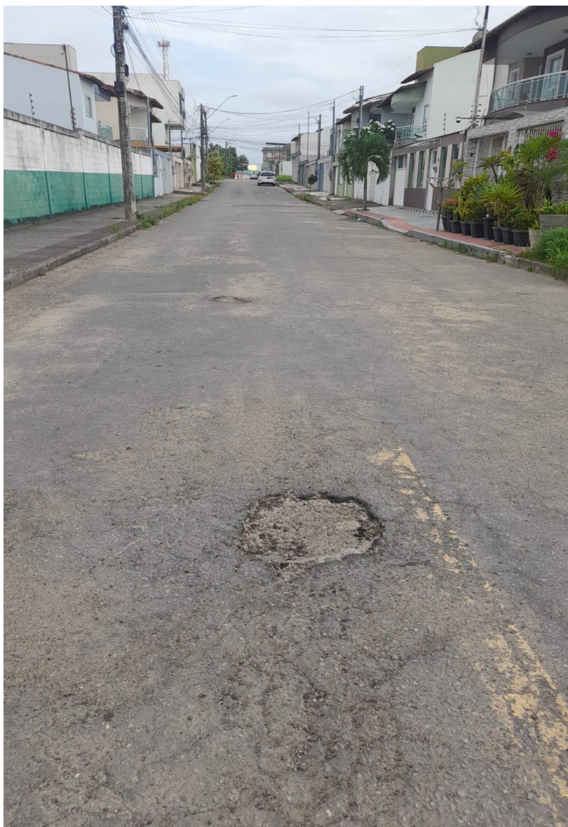
Imagem 3 - Vista da Rua Imbirema, s/n, Colina de Laranjeiras, Serra - ES. Fonte: Gabinete.
