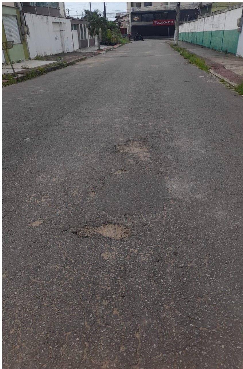
Imagem 2 - Vista da Rua Imbirema, s/n, Colina de Laranjeiras, Serra - ES. Fonte: Gabinete.
