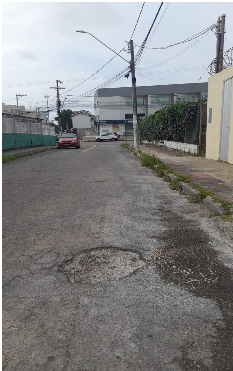
Imagem 3 - Vista da Rua Peroba, nº 6, Colina de Laranjeiras, Serra - ES. Fonte: Gabinete.
