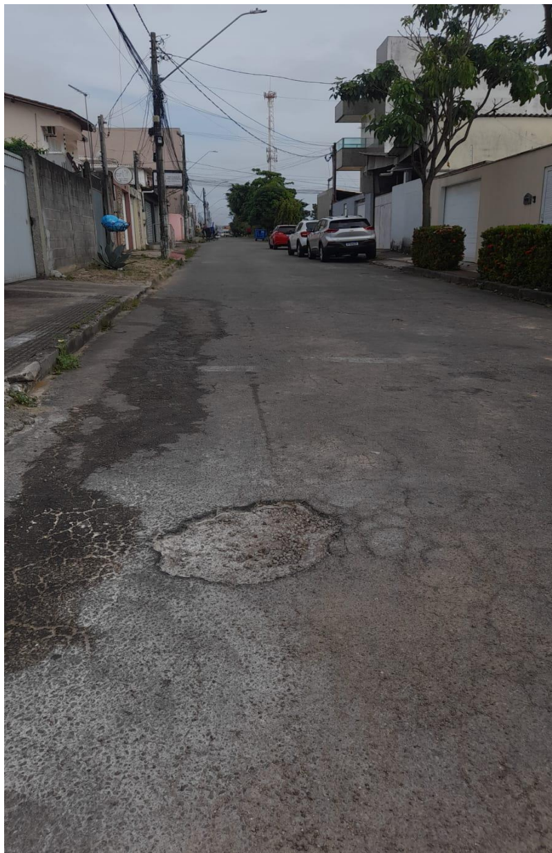
Imagem 2 - Vista da Rua Peroba, nº 6, Colina de Laranjeiras, Serra - ES. Fonte: Gabinete.
