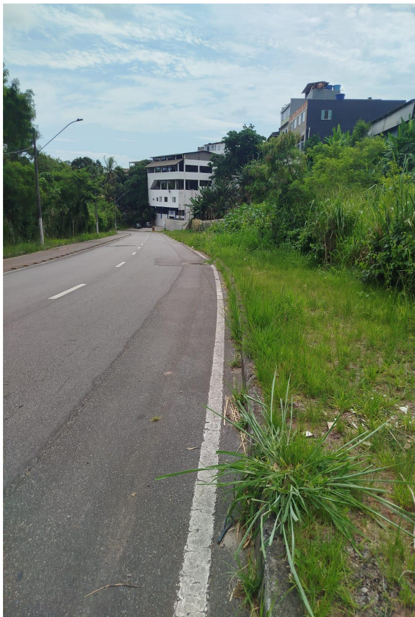
Imagem 3 - Vista da Avenida Carolina, S/N, Colina de Laranjeiras, Serra - ES. Fonte: Gabinete.
