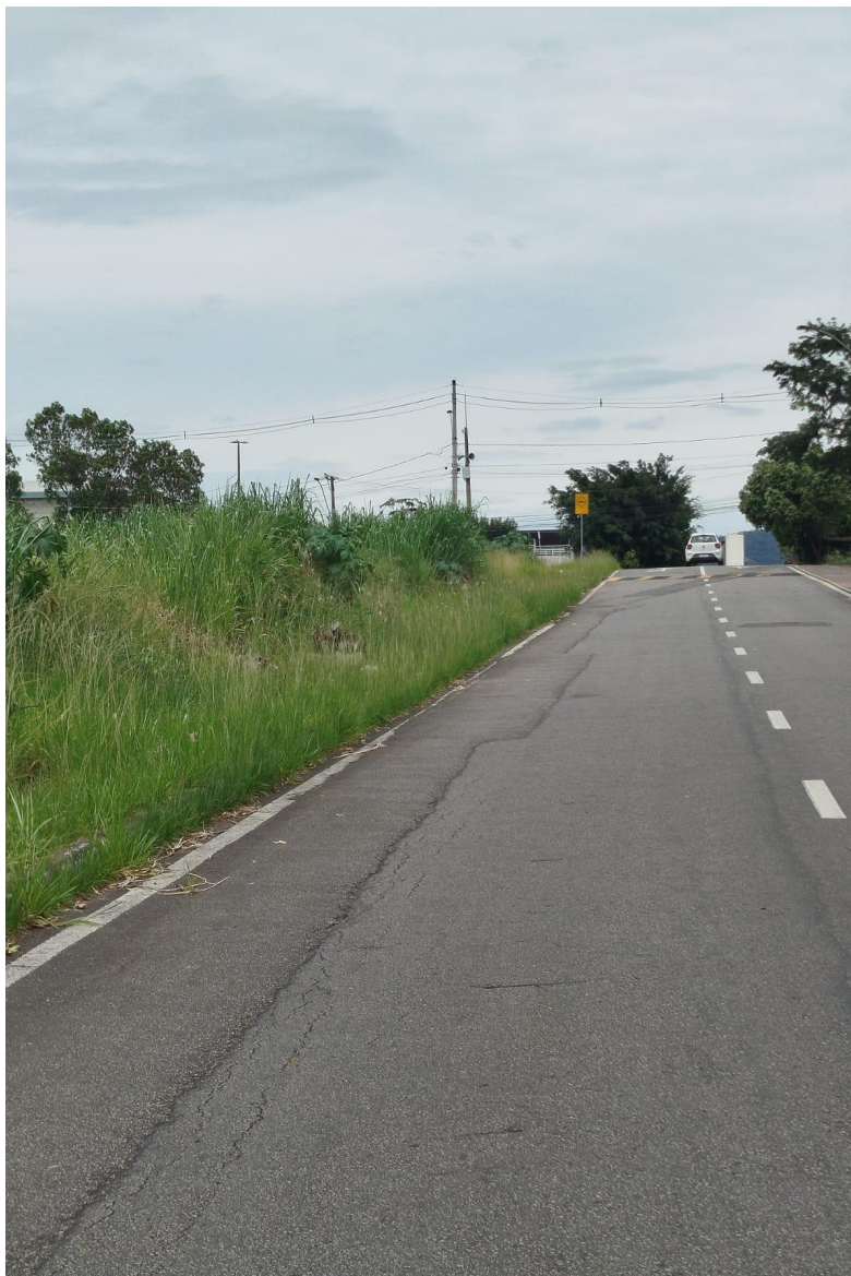
Imagem 2 - Vista da Avenida Carolina, S/N, Colina de Laranjeiras, Serra - ES. Fonte: Gabinete.
