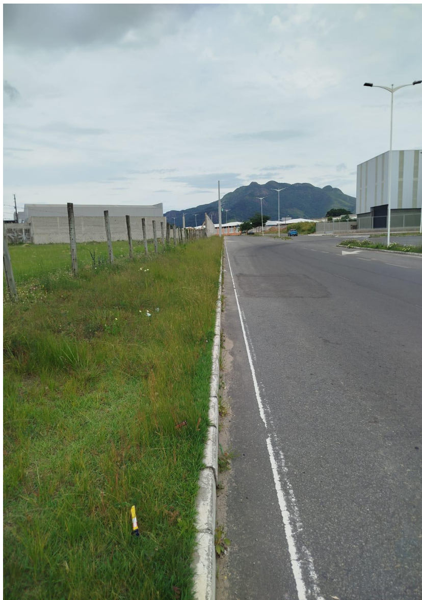
Imagem 2 - Vista da Avenida Delzira Marcelino de Oliveira, S/N, Planalto de Carapina, Serra - ES. Fonte: Gabinete.
