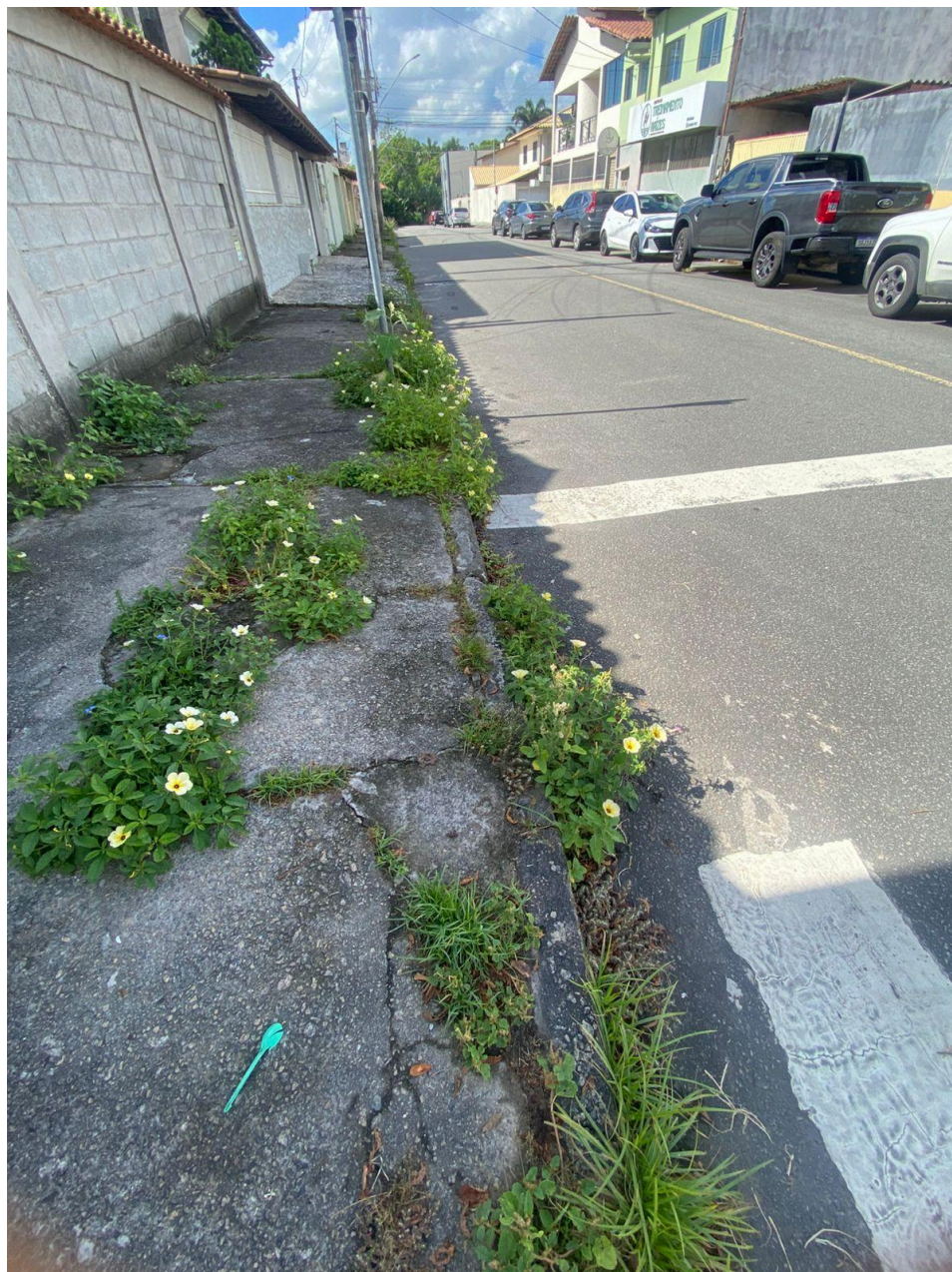
Imagem 2 - Vista da Rua Pablo Picasso, S/N, Parque Residencial Laranjeiras, Serra - ES. Fonte: Gabinete.
