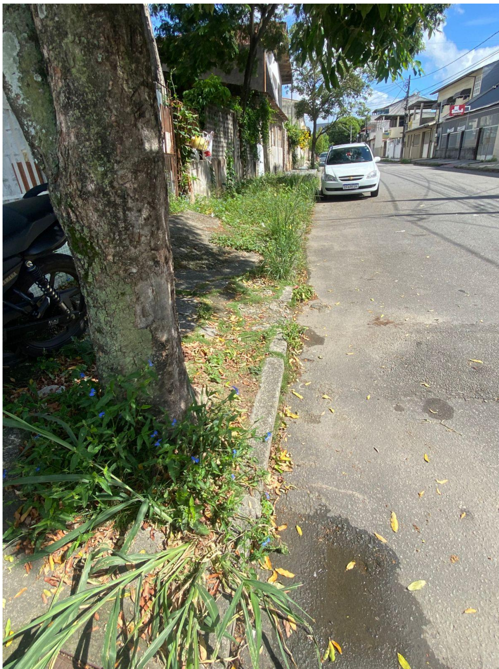
Imagem 2 - Vista da Rua Rafael, S/N, Parque Residencial Laranjeiras, Serra - ES. Fonte: Gabinete.
