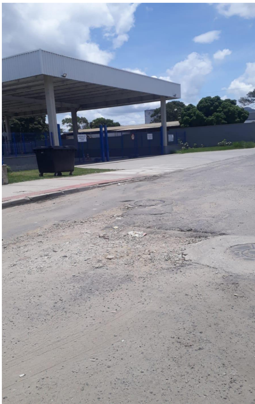
Imagem 2 - Vista da Rua Comendador Roberto Ugolini, s/n, Civit I, Serra - ES. Fonte: Gabinete.
