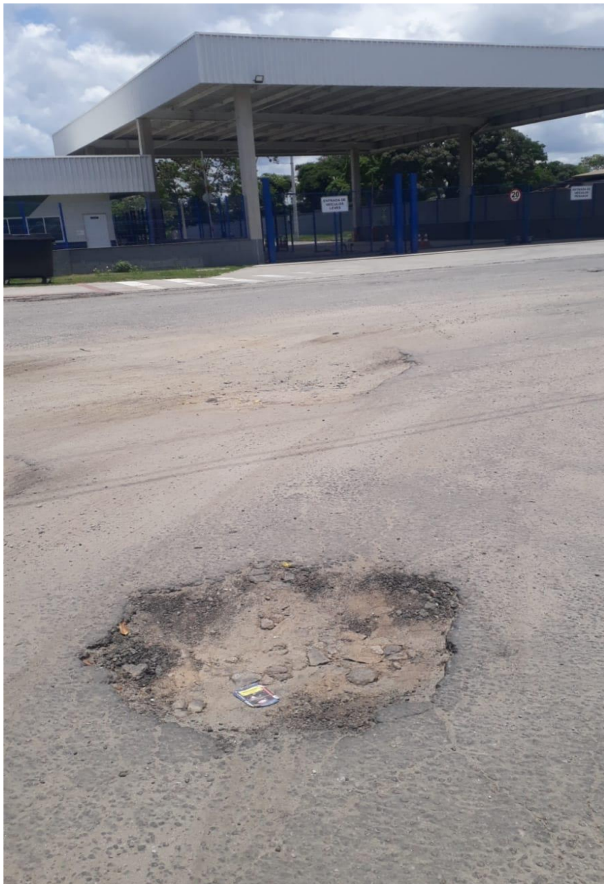
Imagem 3 - Vista da Rua Comendador Roberto Ugolini, s/n, Civit I, Serra - ES. Fonte: Gabinete.
