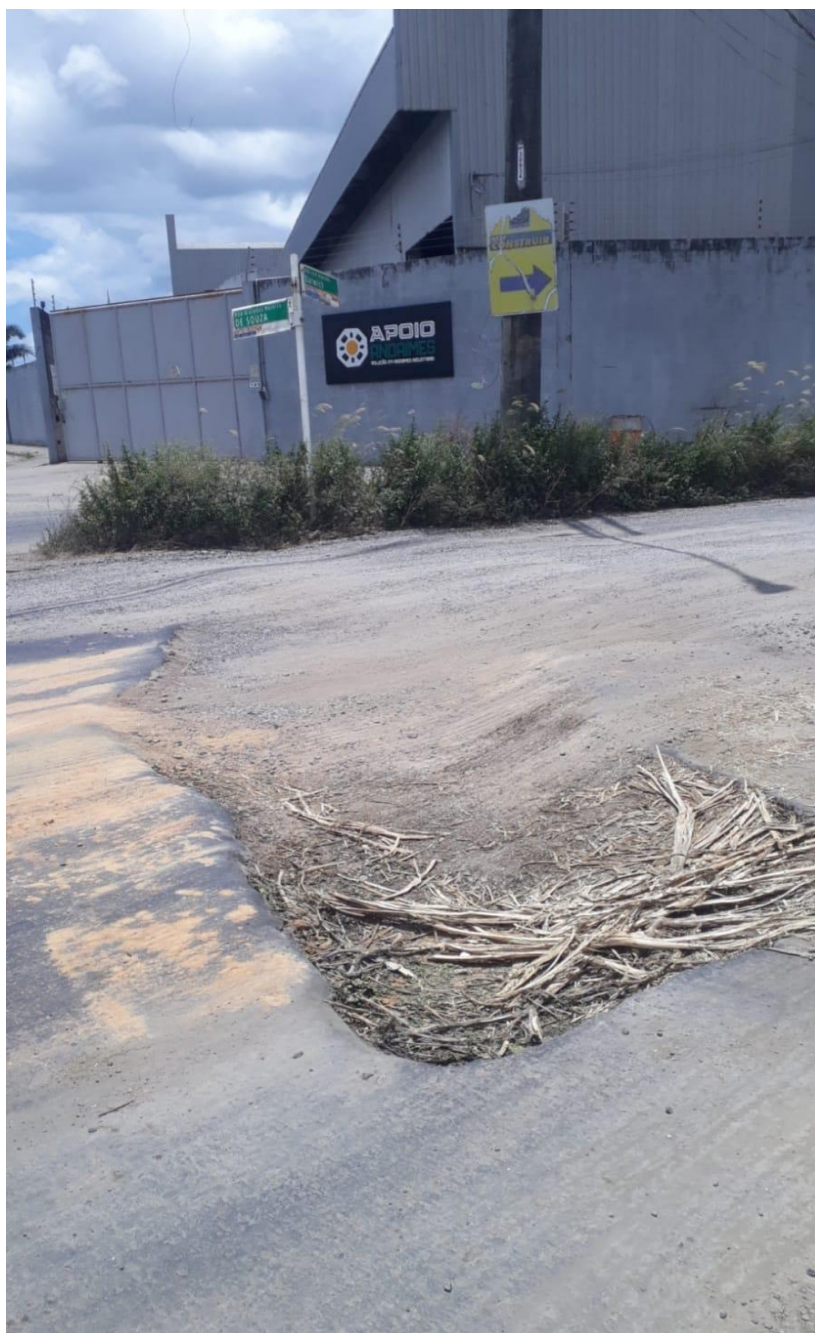
Imagem 2 - Vista da Rua José Oswaldo Darwich, S/N, Civit I, Serra - ES. Fonte: Gabinete.
