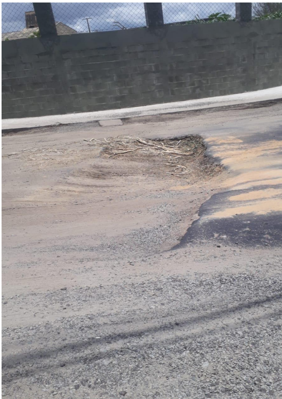
Imagem 3 - Vista da Rua José Oswaldo Darwich, S/N, Civit I, Serra - ES. Fonte: Gabinete.
