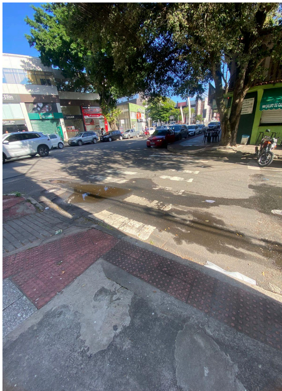
Imagem 3 - Vista da Av. Segunda Avenida, s/n, Parque Residencial Laranjeiras, Serra - ES. Fonte: Gabinete
