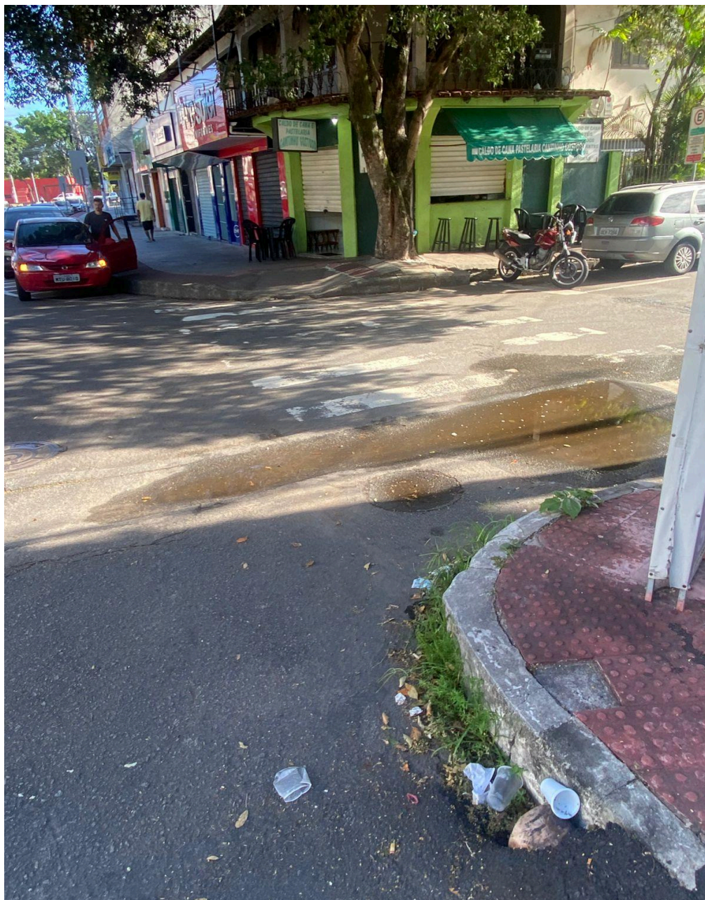
Imagem 2 - Vista da Av. Segunda Avenida, s/n, Parque Residencial Laranjeiras, Serra - ES. Fonte: Gabinete
