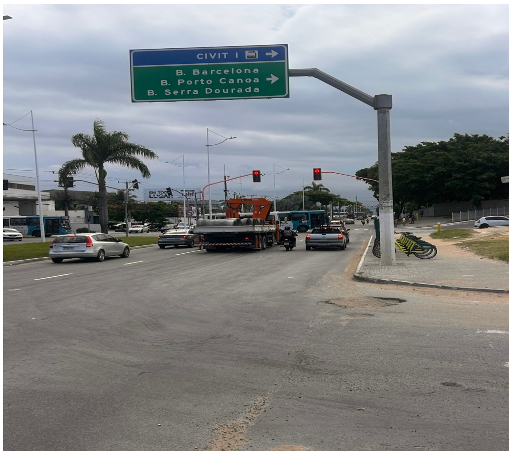
Imagem 2 - Vista da Av. Eldes Scherrer de Souza, Civit II, Serra - ES. Fonte: Gabinete.
