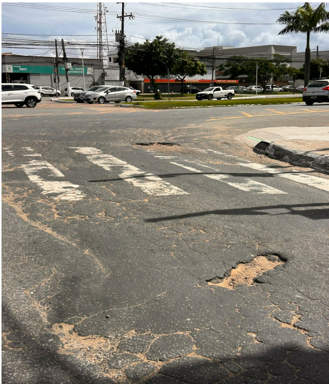
Imagem 3 - Vista do cruzamento da Av. Eldes Scherrer de Souza com a Rua Holdercim, Civit II, Serra - ES. Fonte: Gabinete.
