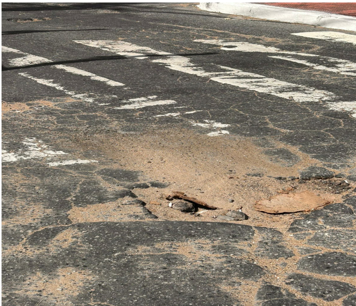
Imagem 4 - Vista do cruzamento da Av. Eldes Scherrer de Souza com a Rua Holdercim, Civit II, Serra - ES. Fonte: Gabinete.
