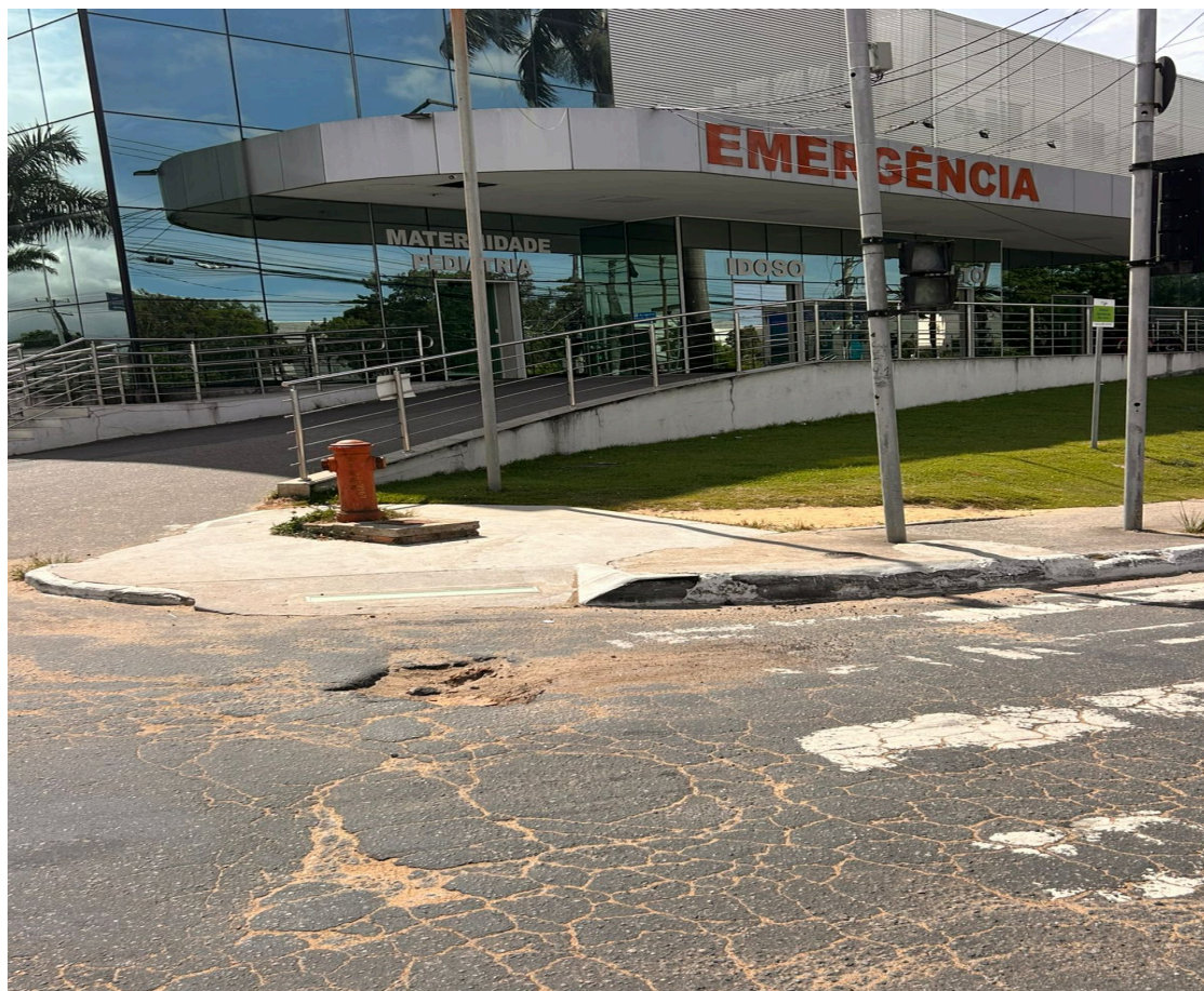
Imagem 2 - Vista do cruzamento da Av. Eldes Scherrer de Souza com a Rua Holdercim, Civit II, Serra - ES. Fonte: Gabinete.
