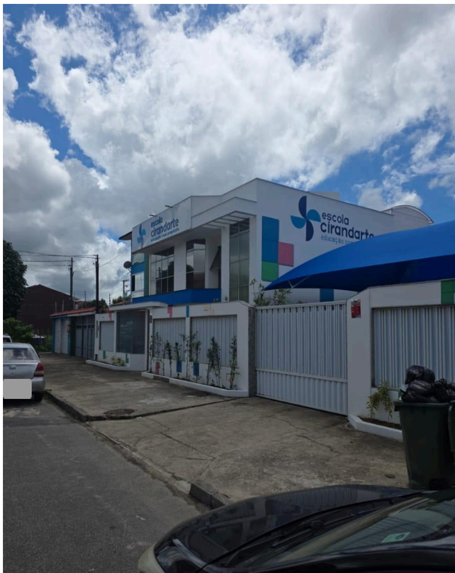
Imagem 2 - Vista da Avenida Macanaíba, nº 17, Colina de Laranjeiras, Serra - ES. Fonte: Gabinete.
