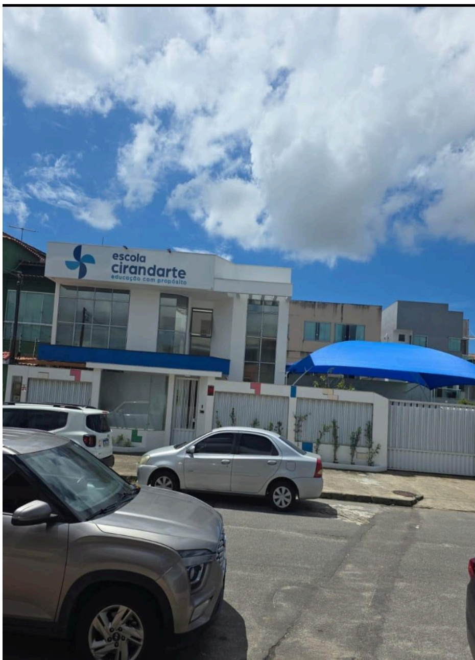
Imagem 3 - Vista da Avenida Macanaíba, nº 17, Colina de Laranjeiras, Serra - ES. Fonte: Gabinete.
