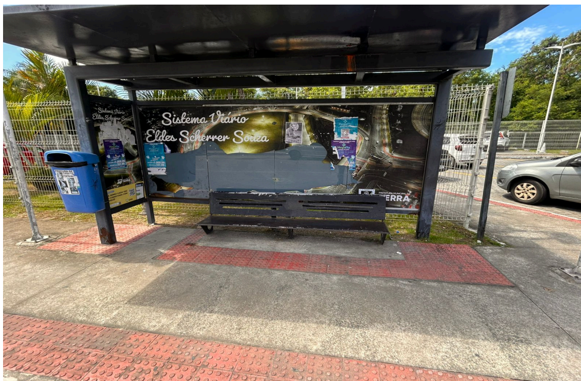
Imagem 2 - Vista do abrigo de ônibus da Av. Guarapari, S/Nº, Valparaíso, Serra - ES. Fonte: Gabinete.
