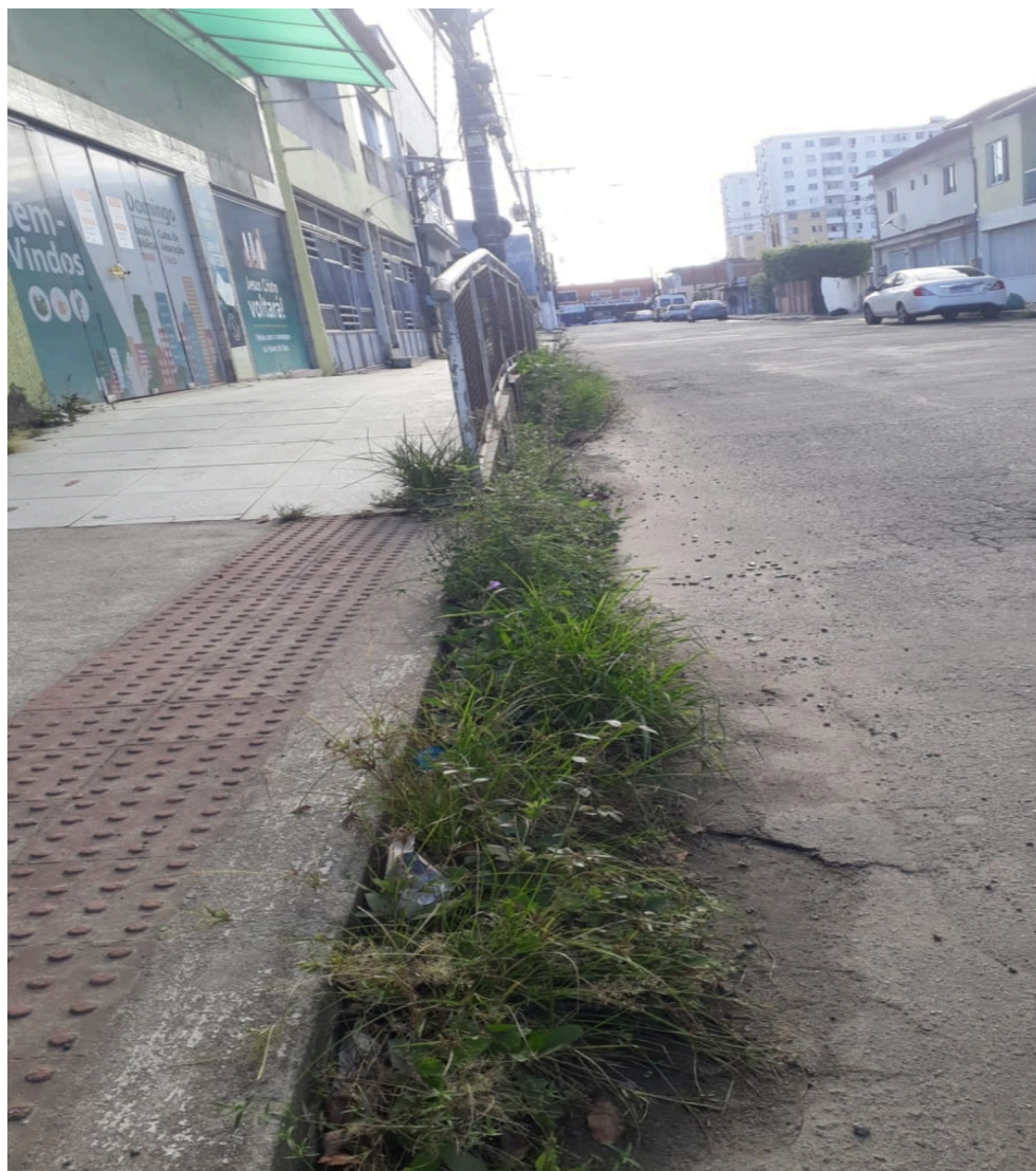
Imagem 2 - Vista da Rua Evaristo da Veiga, s/n ,Chácara Parreiral, Serra - ES. Fonte: Gabinete
