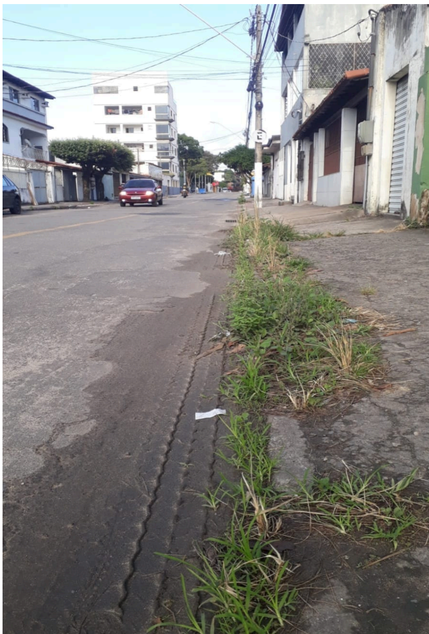
Imagem 3 - Vista da Rua Evaristo da Veiga, s/n ,Chácara Parreiral, Serra - ES. Fonte: Gabinete
