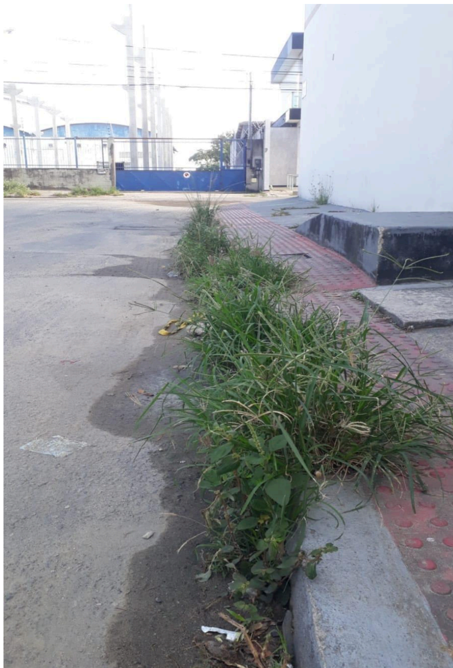
Imagem 2 - Vista da Rua Guilherme de Almeida, s/n, Chácara Parreiral, Serra - ES. Fonte: Gabinete.
