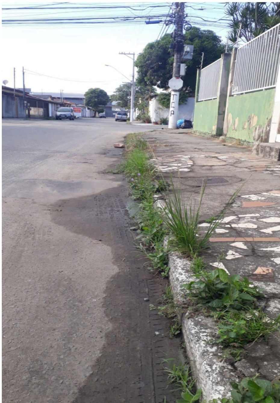
Imagem 3 - Vista da Rua Guilherme de Almeida, s/n, Chácara Parreiral, Serra - ES. Fonte: Gabinete.
