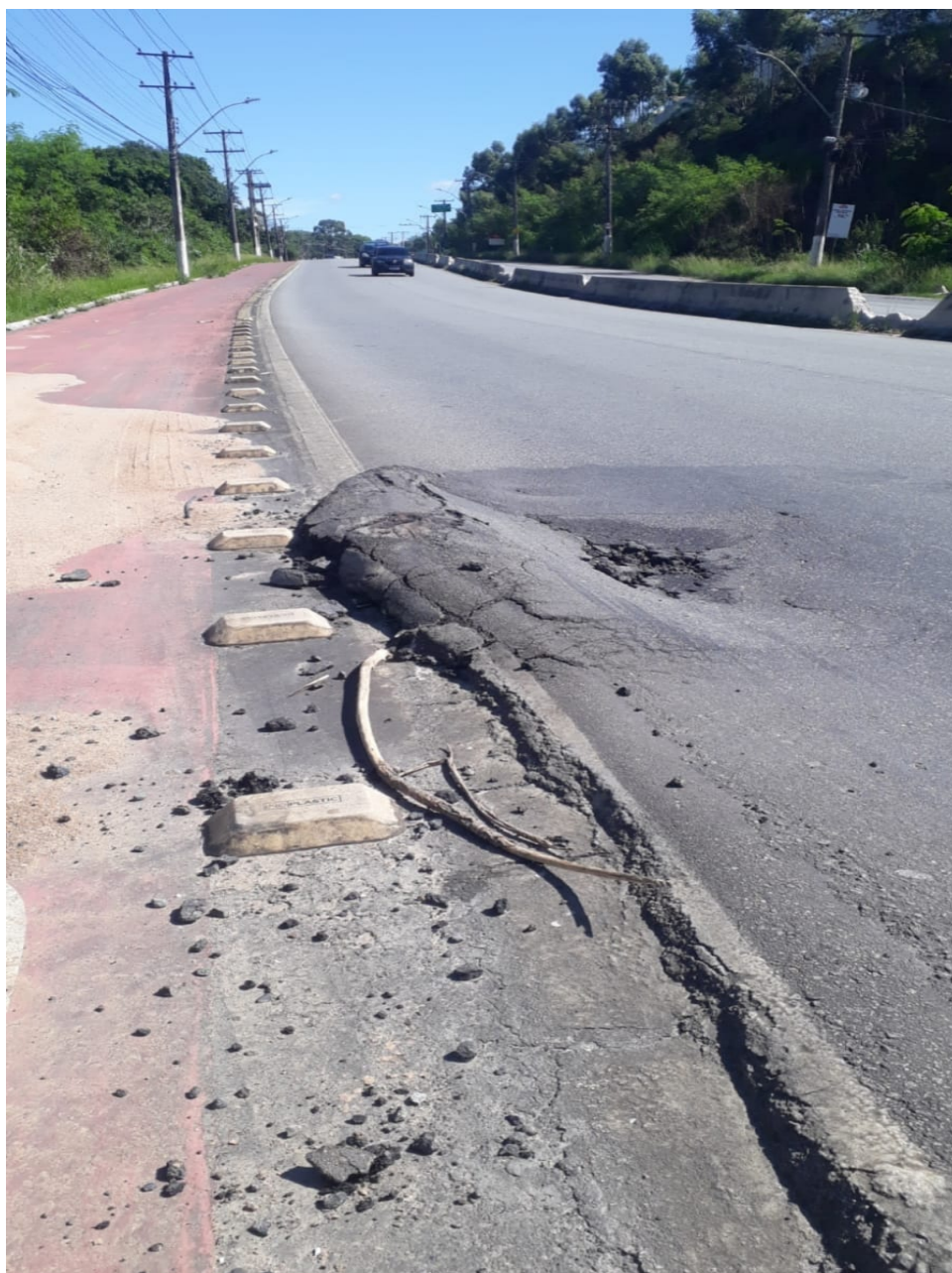
Imagem 2 – Vista da Av. Norte Sul, Civit II, Serra - ES. Fonte: Gabinete.
