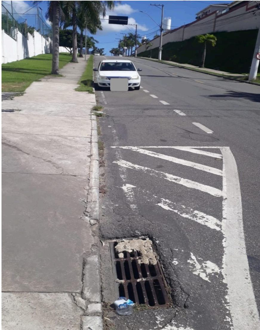
Imagem 2 - Vista da Avenida Braúna, s/nº, Colina de Laranjeiras, Serra - ES. Fonte: Gabinete.
