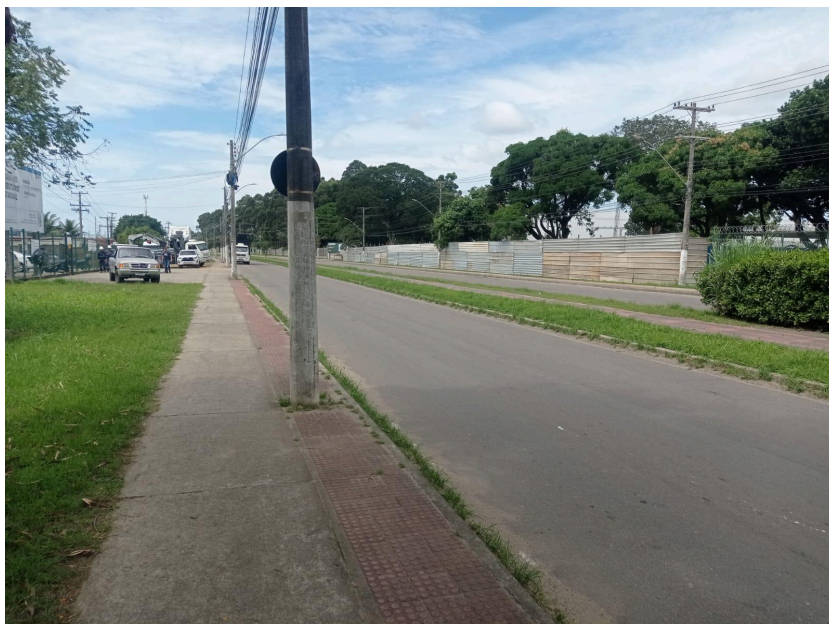
Imagem 1 - Localização da sinalização horizontal. Fonte: Muni cipe.
