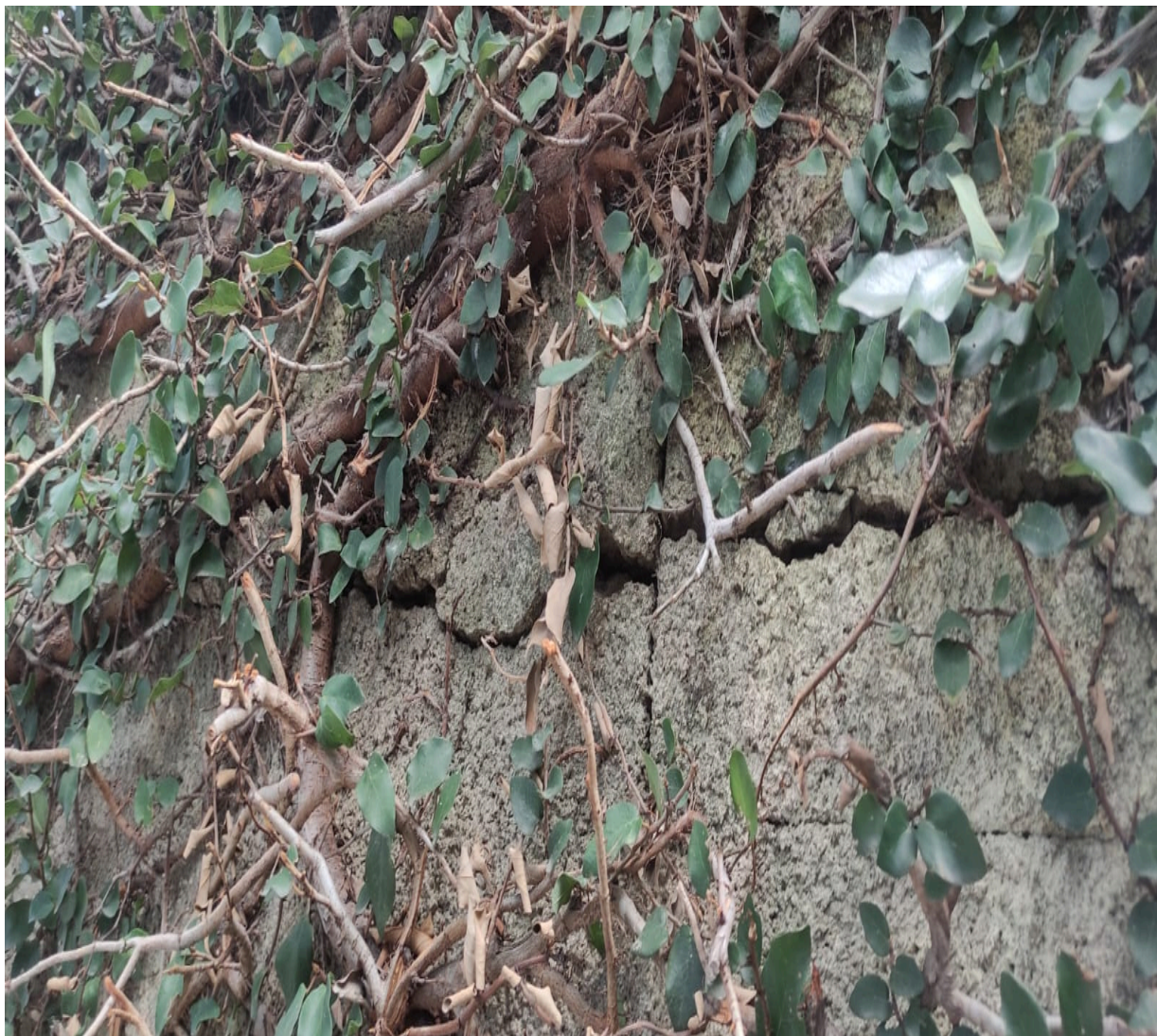
Imagem 2 - Muro do Ginásio de Morada de Laranjeiras. Fonte: Gabinete Externo.
