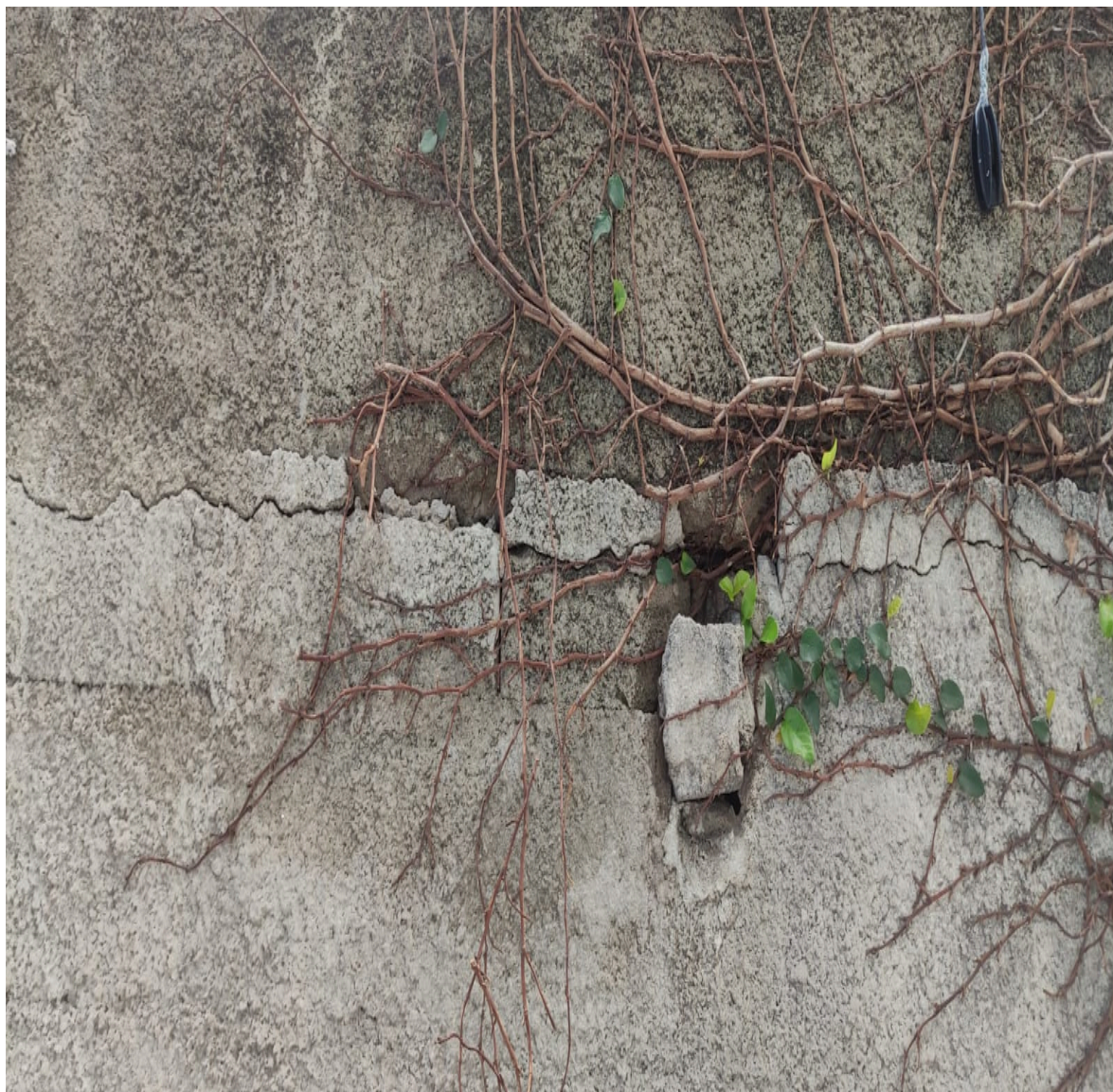
Imagem 1 - Muro do Ginásio de Morada de Laranjeiras. Fonte: Gabinete Externo.
