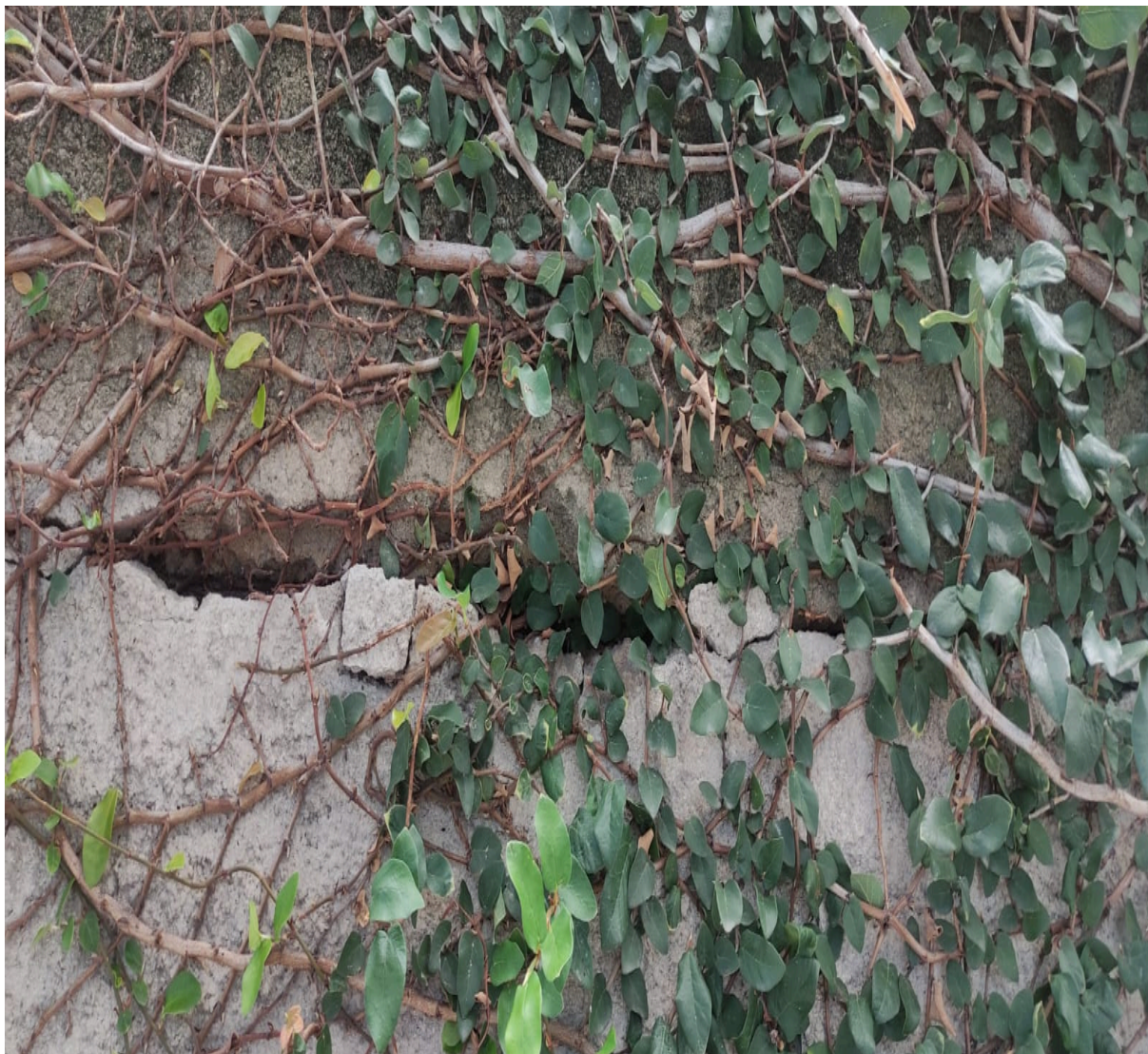
Imagem 3 - Muro do Ginásio de Morada de Laranjeiras. Fonte: Gabinete Externo.
