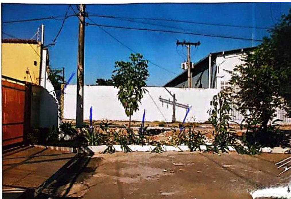
Imagem da referida rua antes da demolição do muro
