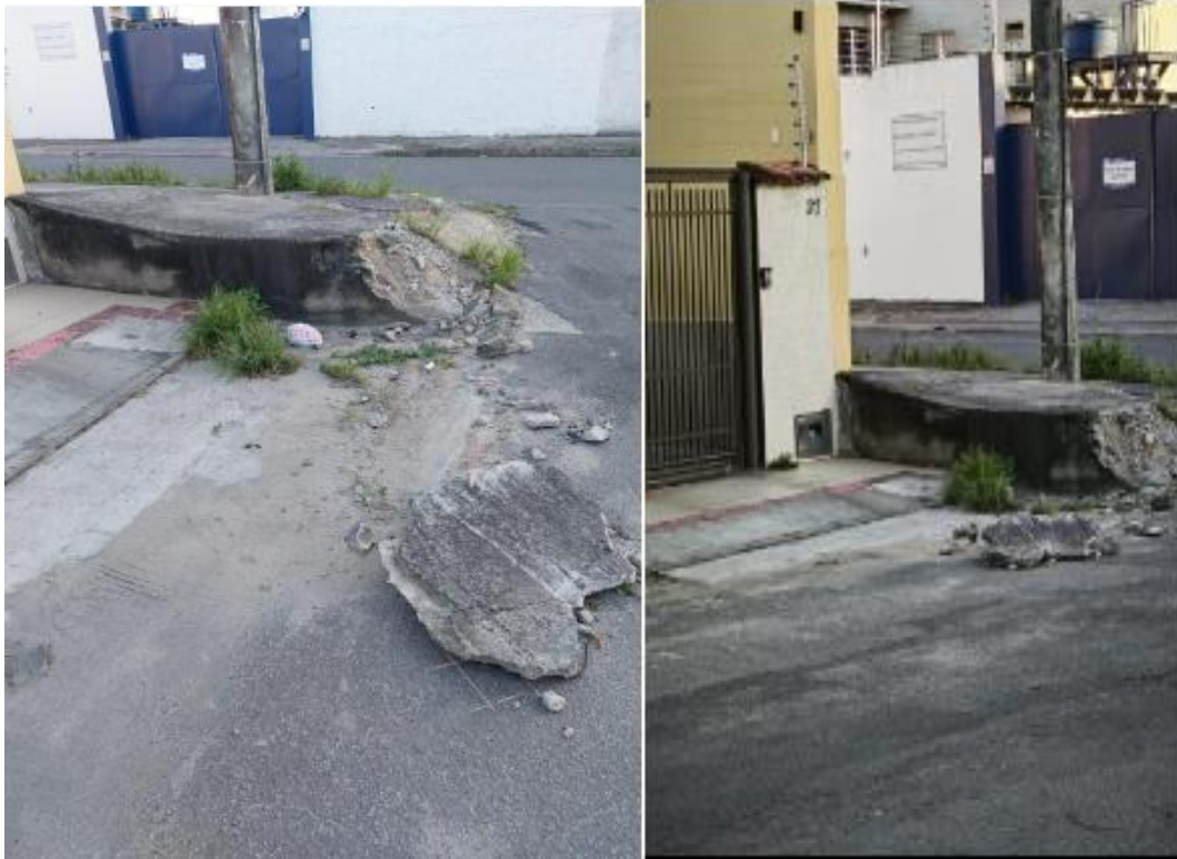
Imagem da rua após a demolição do muro
