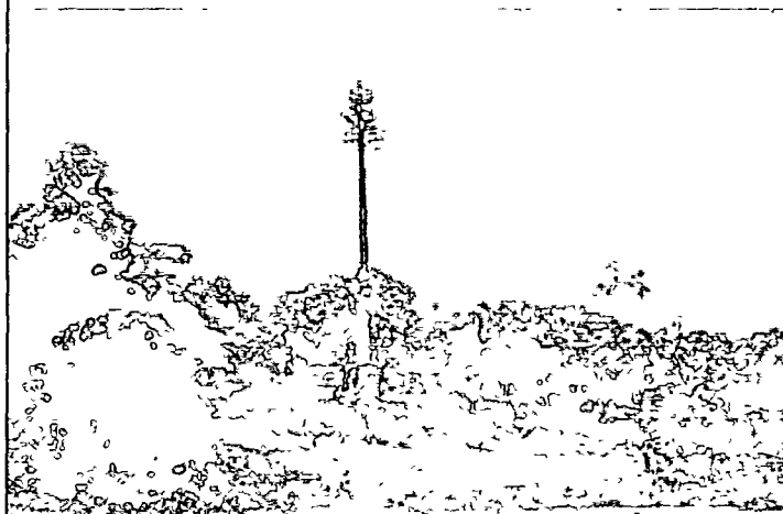
FIGURA 1: Torre camuflada da UFMG.
